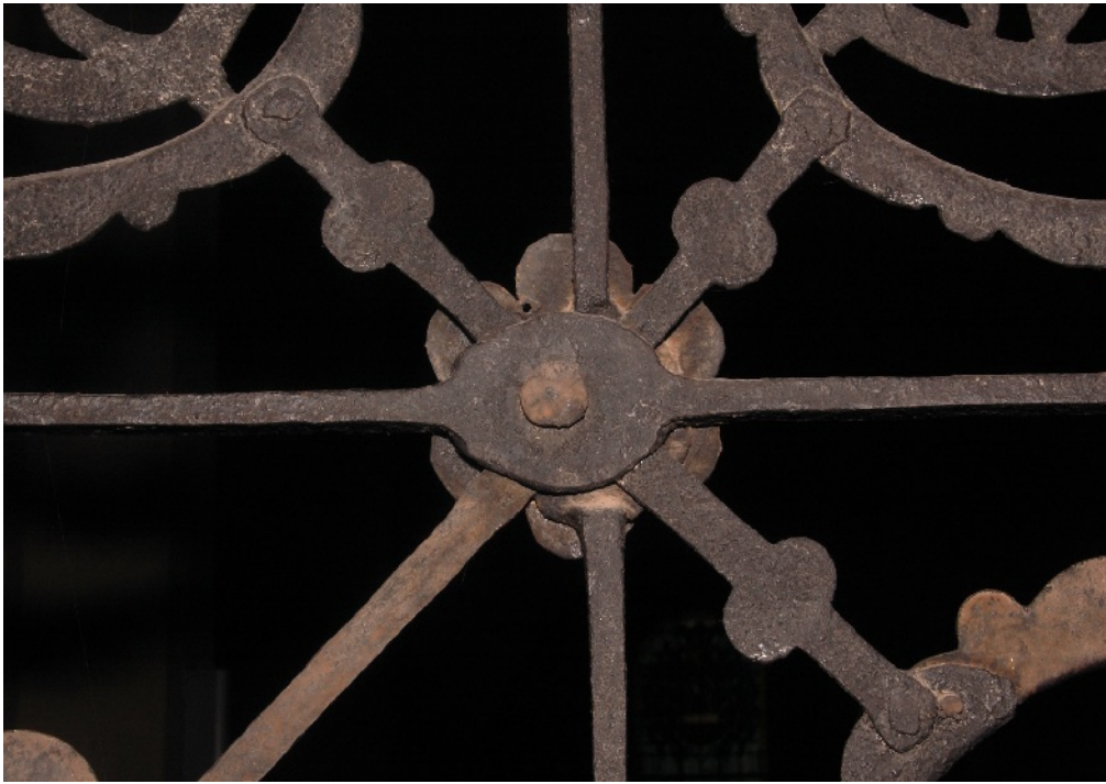
Kuva 35. Kijkin aidan vaakunapaneelin taustapuolta. Uusitut osat näkyvät kuvassa eri sävyisenä kuin alkuperäiset.
