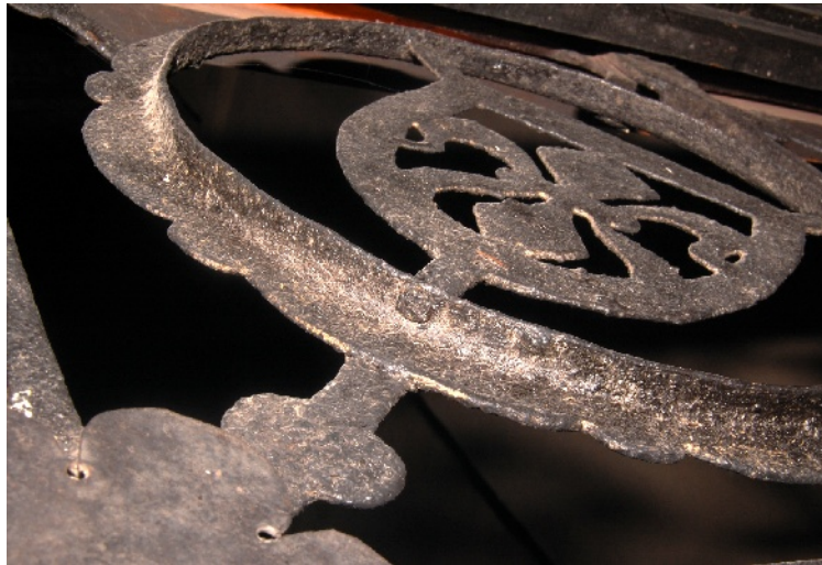
Kuva 33. Kijkin aidassa vaakunakilven kiinnittyminen profiilirenkaan huullokseen.
