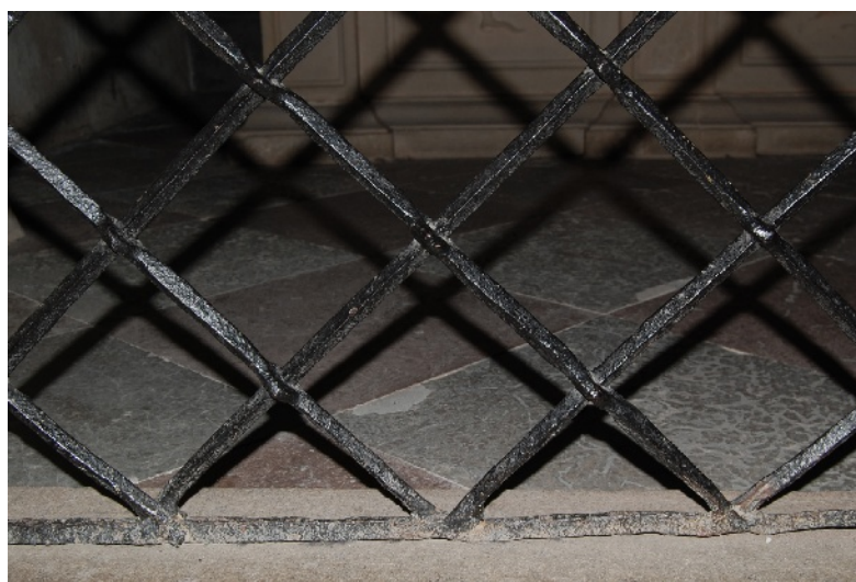
Kuva 22. Vinoneliöruudukon tankojen kiinnittyminen ahjohitsauksella kehikon alarimaan.
