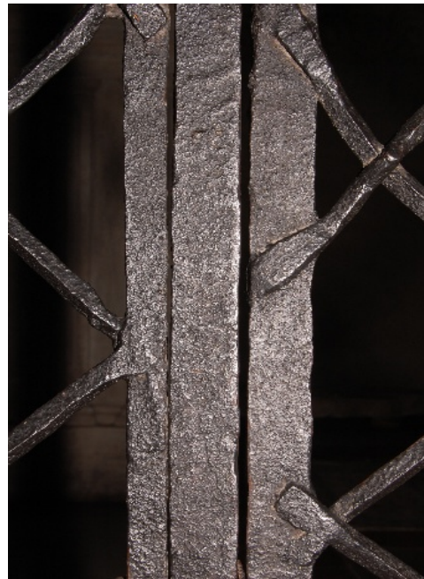
Kuva 44. Vinoneliöruudukon päiden ahjohitsaus.
