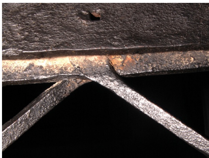
Kuva 23. Vinoneliöruudukon tankojen kiinnittyminen ahjohitsauksella kehikon ylärimaan.
