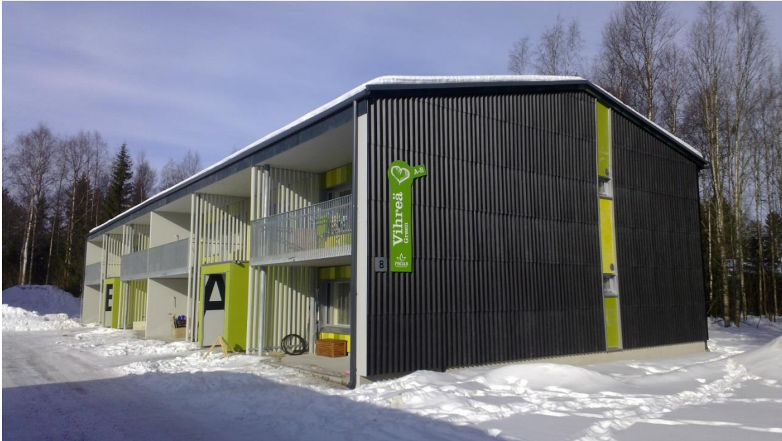
KUVA 1. PSOAS Virkakatu 8 -passiivitalo sivusta
