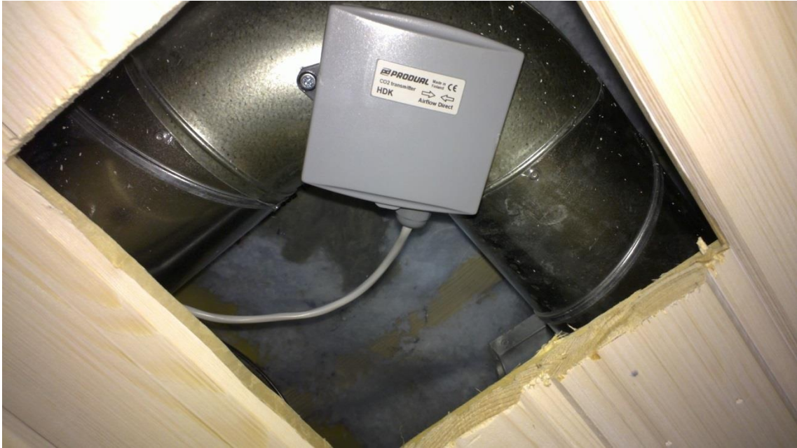
KUVA 14. Poistokanavan CO 2 -anturi
