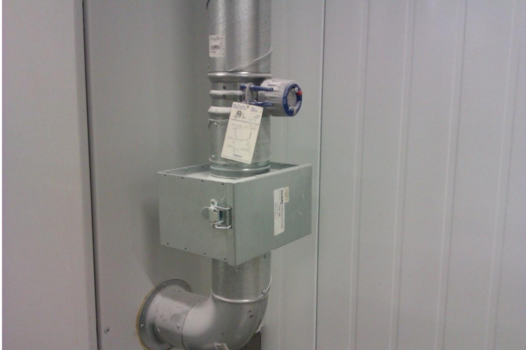
KUVA 6. Sähkökeskuksen ilmanvaihtoputki ja ilmansuodatin
