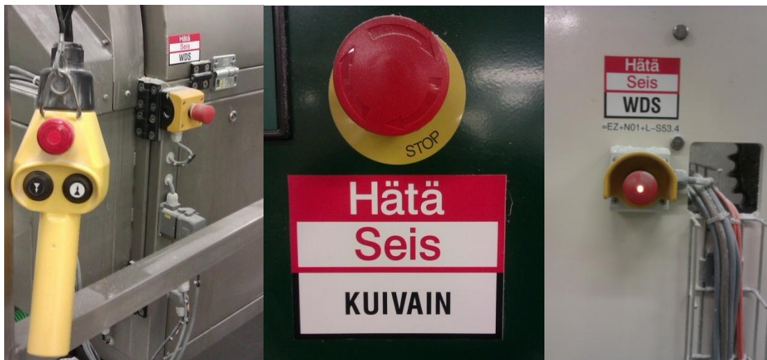
KUVA 17. Hätäpysäytyspainike ohjauslaitteessa (vas.) sekä /muita hätäpysäytyspainikkeita
