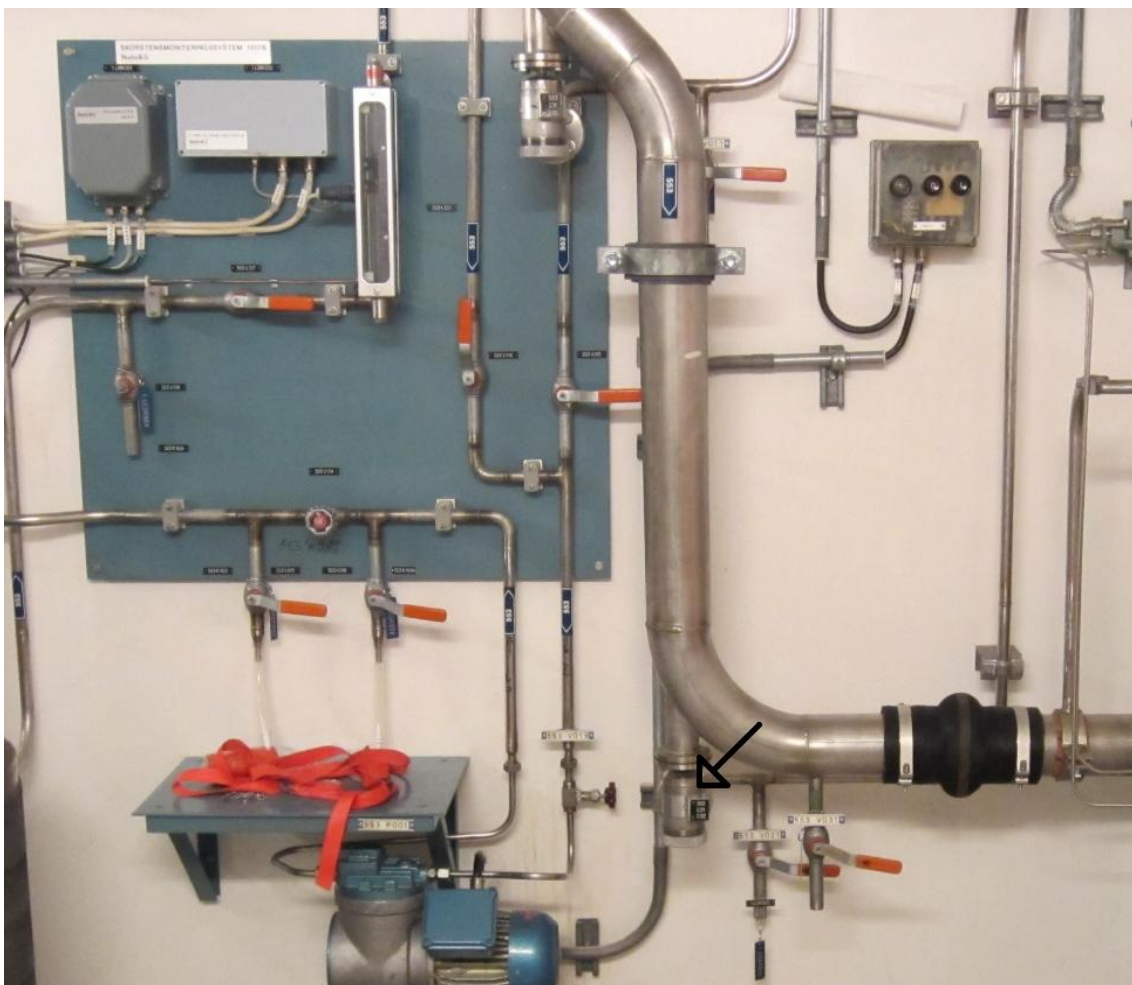
KUVA 8. Reaktorirakennuksen poistoilmapiipun näytteenottolinja, nuolella merkitty suodattimen paikka. (Kuva: Petri Hovi 2013)
