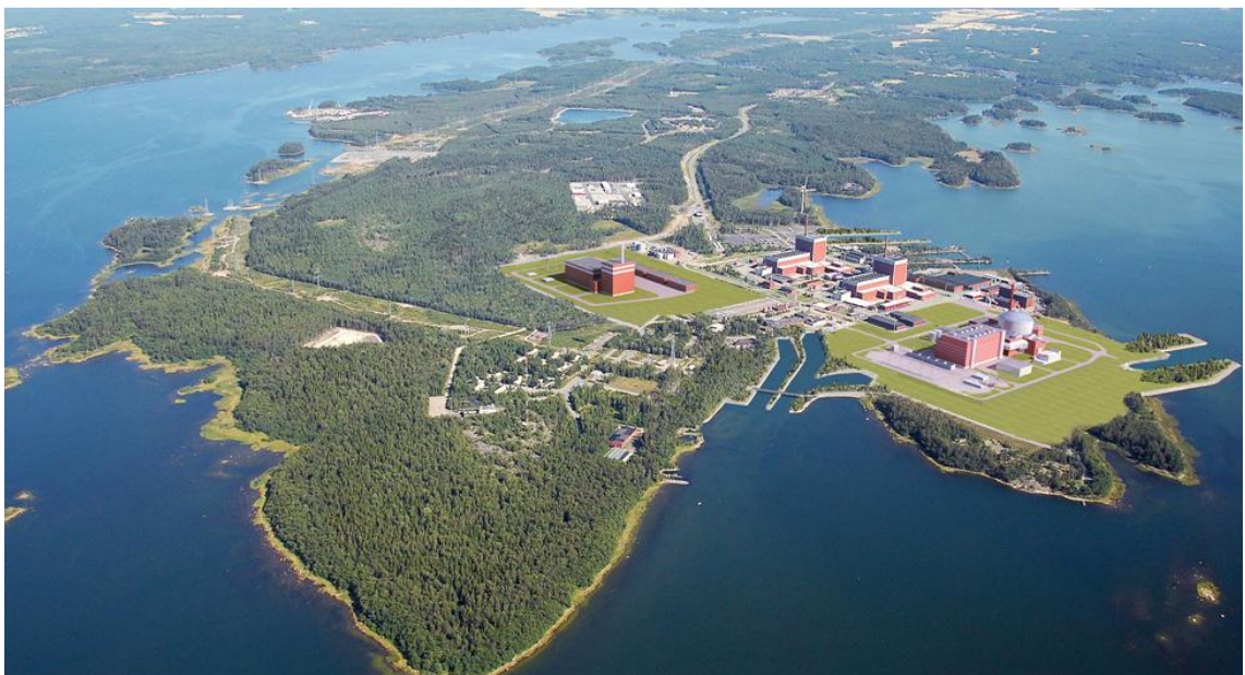
KUVA 1. Olkiluodon voimalaitosalue (Kuva: tvo.fi/voimalaitokset )
