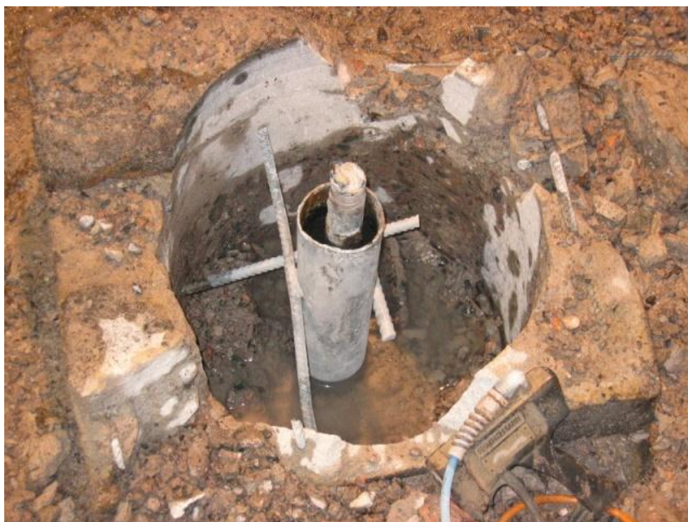
Figur 58. Gamla fundamentbultarna var ingjutna i en bultficka. Dessa borrades bort med dimantsåg och därefter söndrades gamla betongen genom vattenpikning. (Författarens bild).
