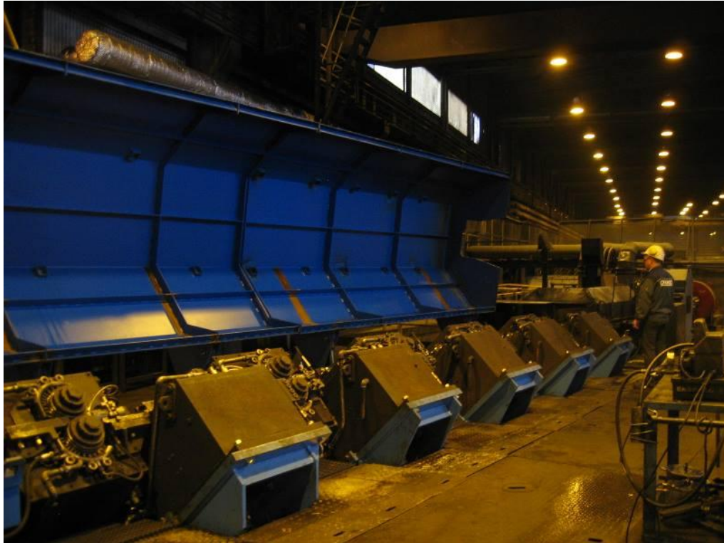
Figur 63. Trådblockets alla delar monterade. Valsparen och valsarna som formar den färdiga produkten är på plats. Dagen före produktionen startade såg det ut såhär. (Författarens bild).
