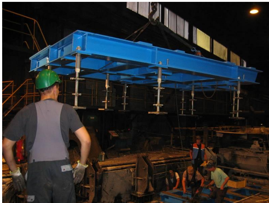
Figur 59. Nya fundamentet lyfts ner på plats efter att fundamentbultarna monterats. (Författarens bild).
