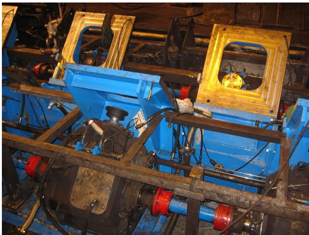
Figur 62. Växellådorna är uppriktade och mellanaxlarna monterade. Rören har också lagts tillbaka. (Författarens bild).
