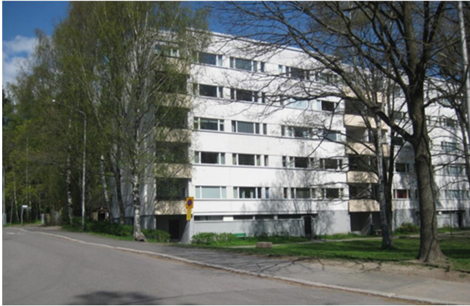
Kuvio 2. 1965 rakennettu betonielementtikerrostalo Espoon Lählerannassa
