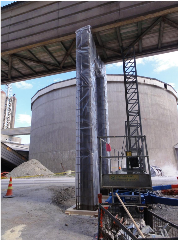
KUVA 6. YARA Siilinjärvi. Betonipilarin manttelointi
