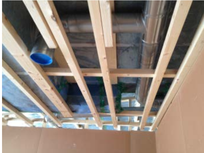
KUVA 2. 1-kerroksisen talon tuloilmakanava Kaistalla
