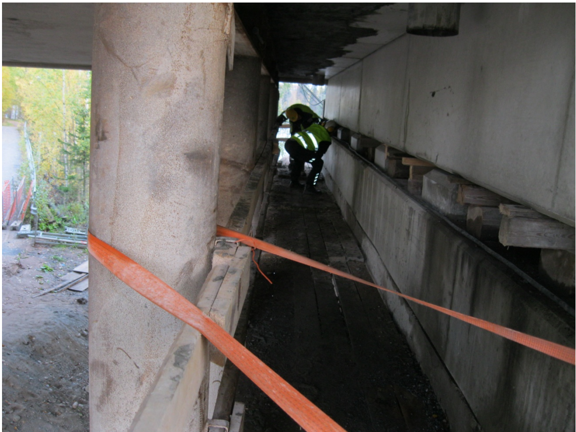
KUVA 17: Laakereiden ja kannen välisen etäisyyden tarkistus sekä terästuen varmistus kuormaliinalla ennen tunkkausta
