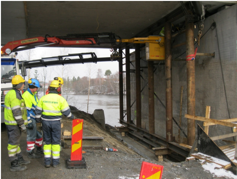
KUVA 15: Tuen nosto ja varmistus ketjuilla (Kuva: Vesa Salmijärvi 2012)
