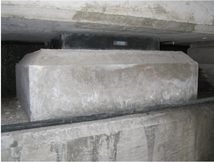
KUVA 18: Uusi kumilevylaakeri
