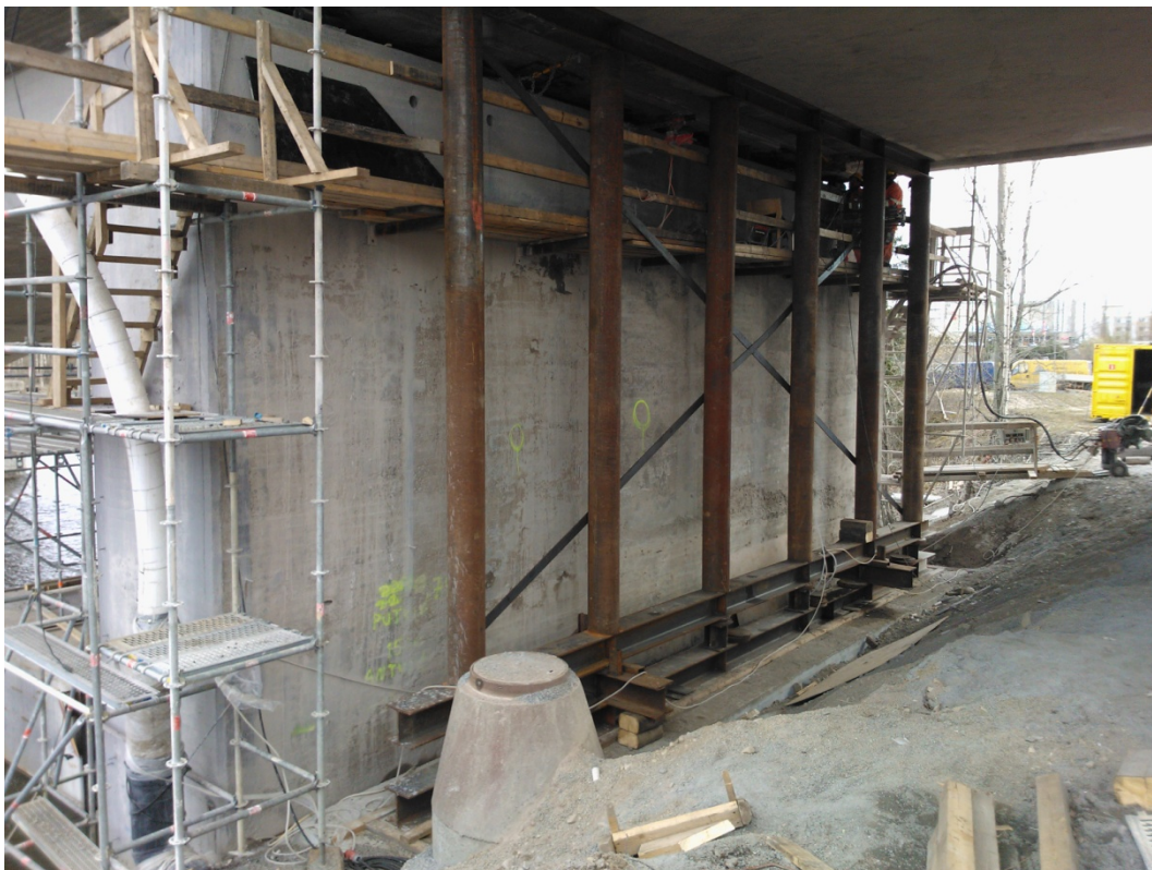
KUVA 10: Valmis väliaikainen tuenta
