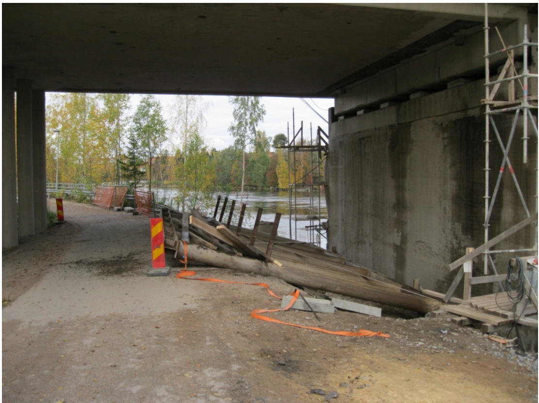
KUVA 19: Terästuki kaadettuna luiskaan
