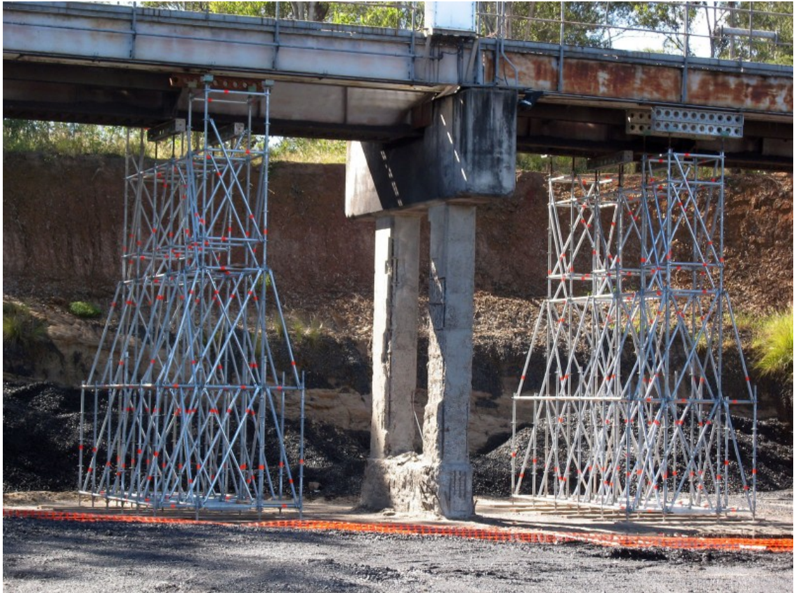
KUVA 4. Telineillä toteutettu väliaikainen tuenta (Kuva: Stroyrent)
