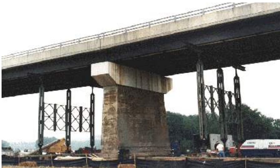
KUVA 3. Silta tuettuna valmiilla teräsrakenteilla (Acrow Bridges)
