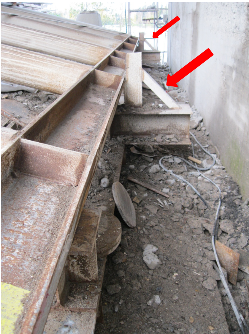
KUVA 14: Työnaikaiset poikittaiset HE-palkit ja topparit
