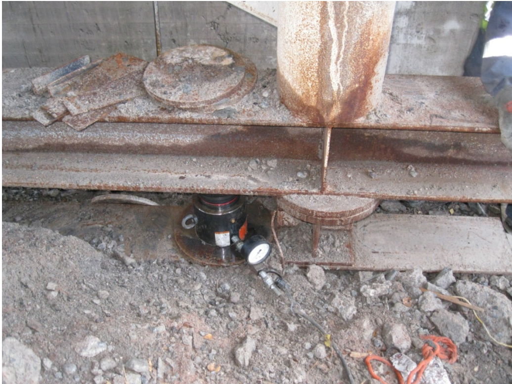
KUVA 16: Tunkit asetettiin tuen pilareiden viereen tunkkaustasolle
