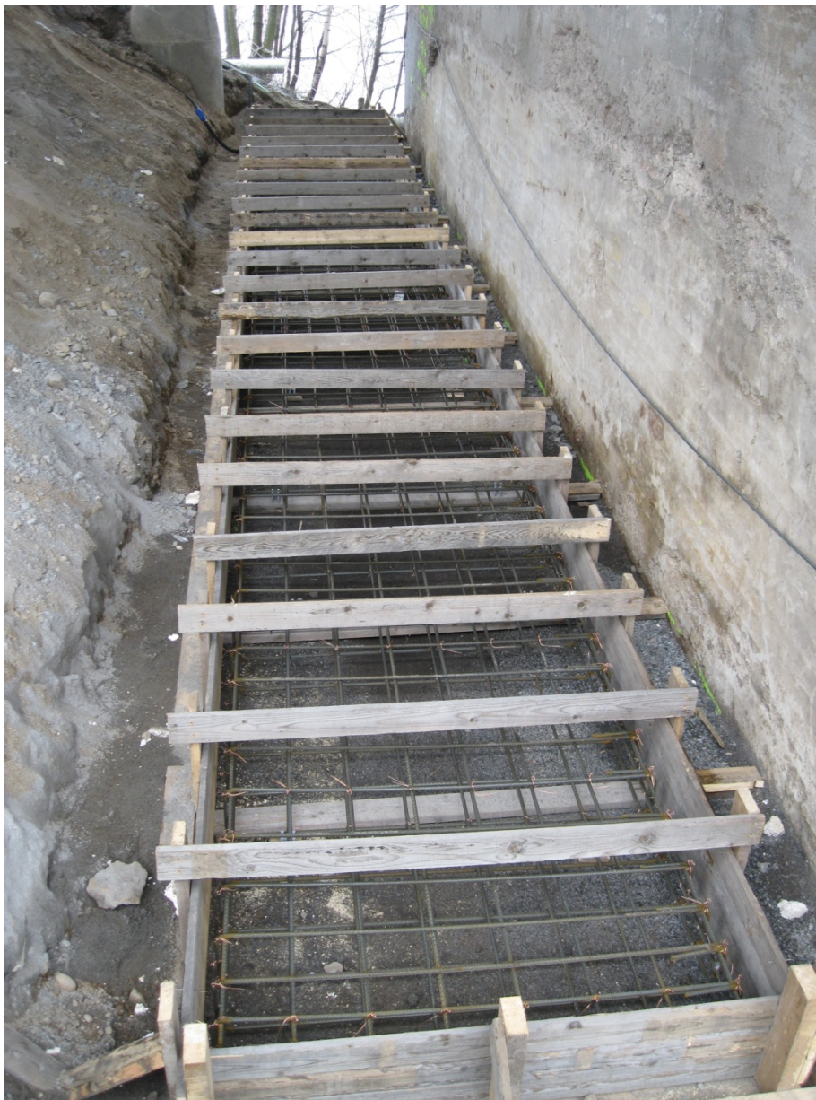
KUVA 13: Väliaikaisen tuen anturan muotti ja raudoitus (Kuva: Vesa Salmijärvi 2012)
