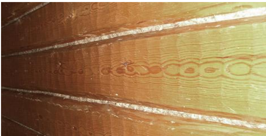
Kuva 13. Suurella lamellilaikalla ”piilutettua” hirsiseinää.
