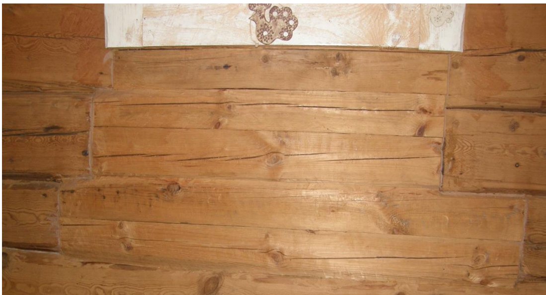
Kuva 28. Ikkunan alapuolen hirret kunnostettu
