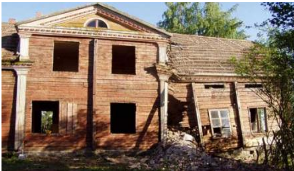
Kuva 3. Siirtäminen on alkanut käyttökelpoisen materiaalin purkamisella [4].
