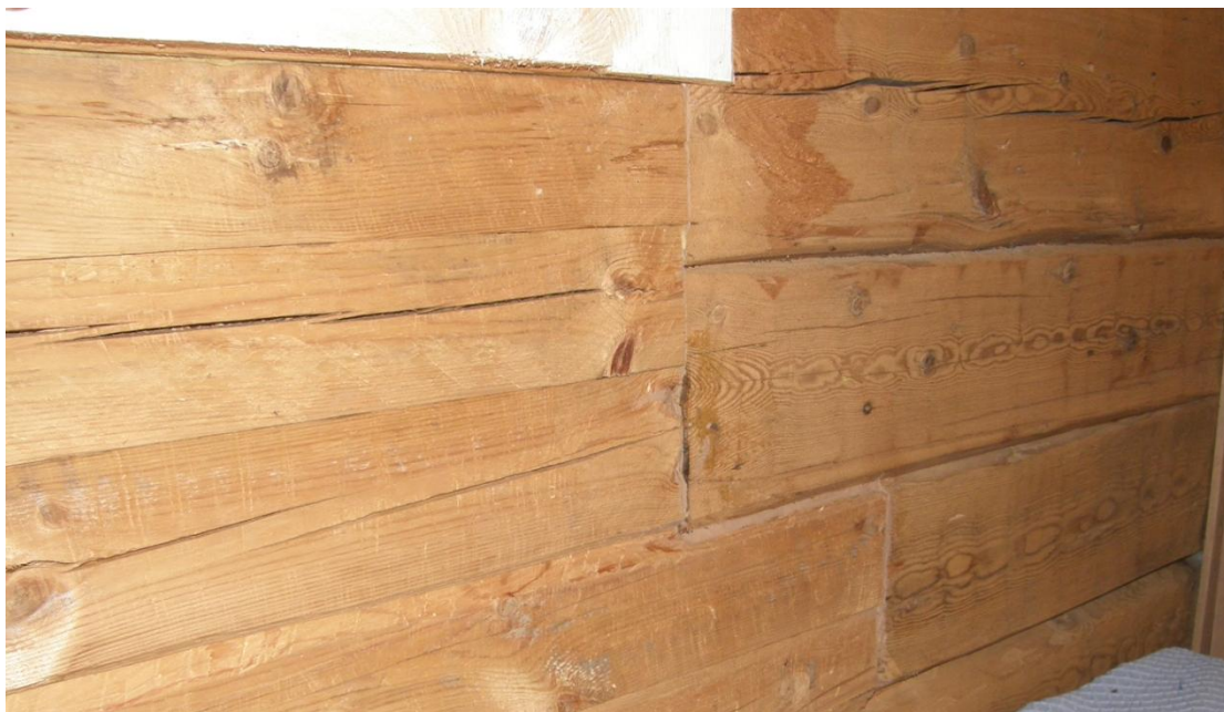
Kuva 29. Ikkunan alapuolen hirret kunnostettu
