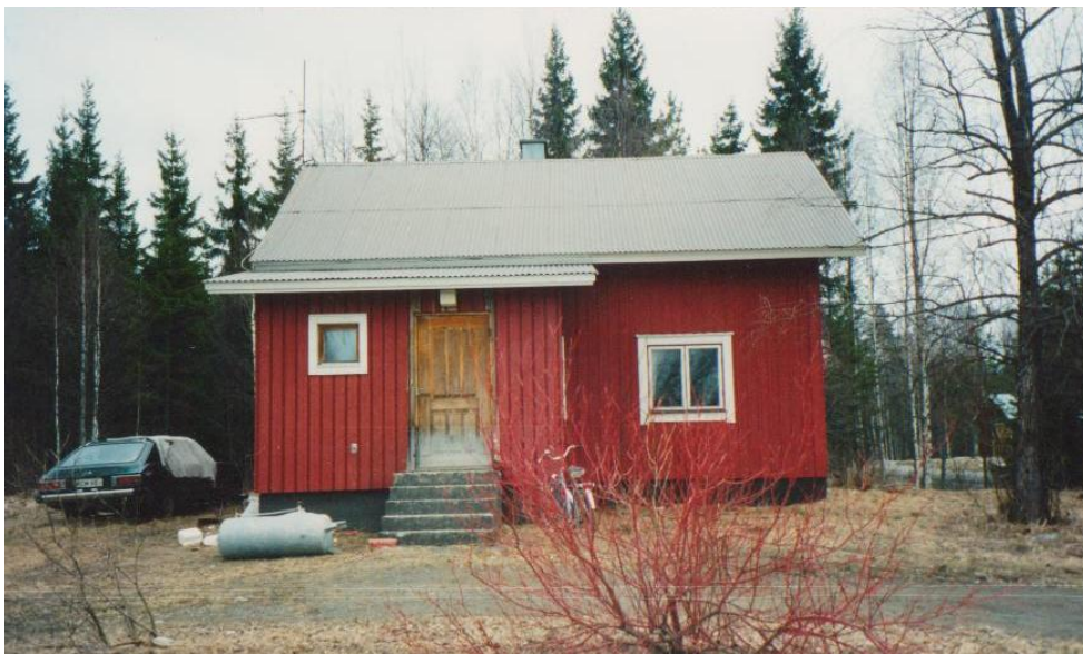
Kuva 7. 1950-luvulla rakennettu hirsirunkoinen mökki Kontiolahdessa. Opinnäytetyön kohde.
