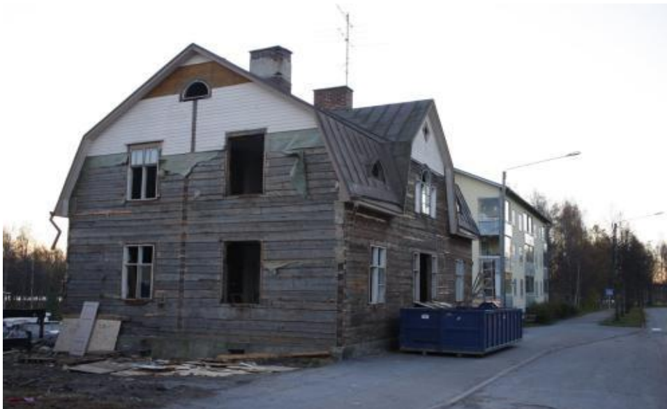
Kuva 1. Purkamispäätöksen saanut talo Vaasassa [2].
