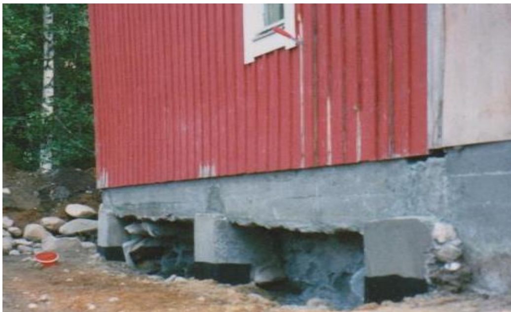
Kuva 76. Pilareiden välistä voi nähdä kellarin säästöbetoniseinän.
