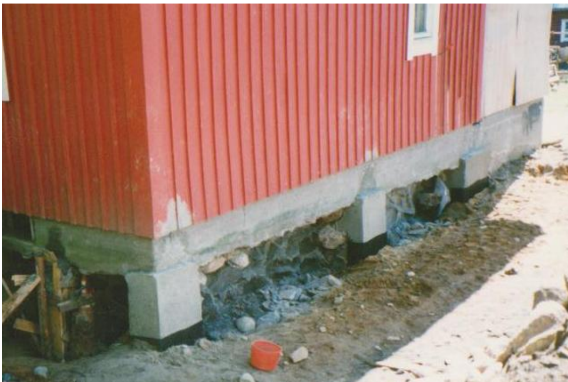
Kuva 45. Hirsirunko teräsbetoni pilareiden varassa eli perustussuunnitelman 2. vaihe.
