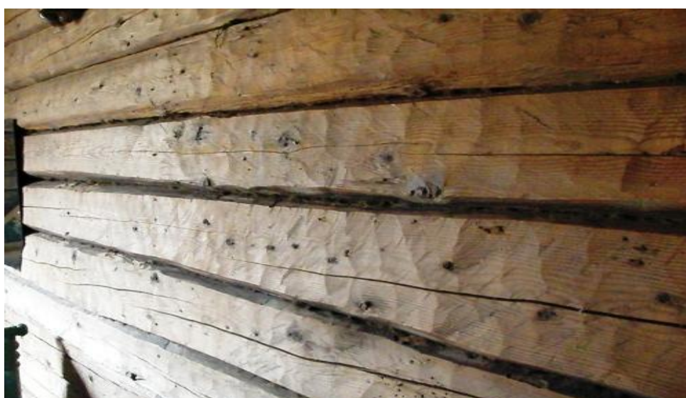
Kuva 16. 1880-luvulla kirveellä piiluttua kamarin seinää.
