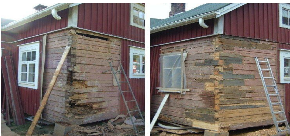
Kuva 26. Lahonneen nurkan paikkausta. Korjaukset on rajoitettu vain vaurioituneelle alueelle. Koko hirttä ei aina kannata vaihtaa. [36]
