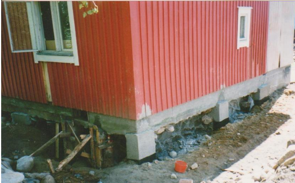
Kuva 75. Vanha sokkeli tuettiin teräsbetonipilarein, takaseinällä painevalumuotti vielä purkamatta.
