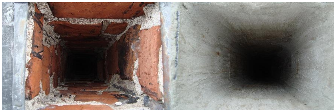
Kuva 64. Melko hyväkuntoinen hormi massattuna oikealla. [50]
