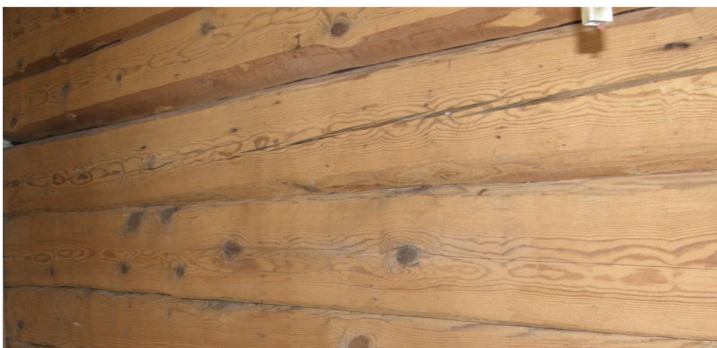
Kuva 11. Hiekkapuhallettua hirsipintaa, 1800 luvulla tehty piilujälki on tuhottu. Pinta on karhea ja kiilloton. Arvokas piilujälki erottuu hyvin himmeästi.
