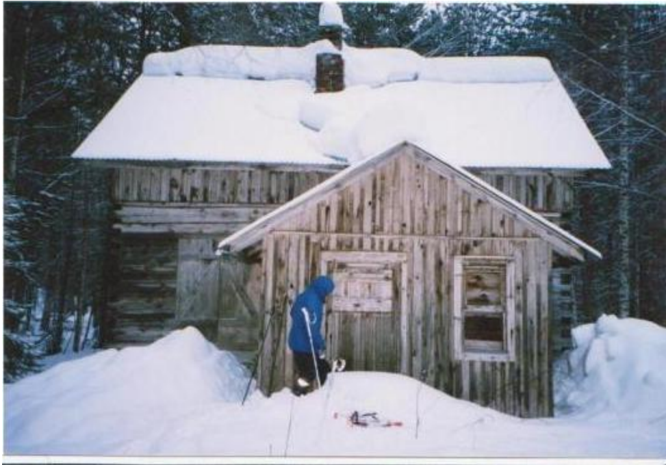
Kuva 6. 1940-luvulla rakennettu hirsirunkoinen mökki Hammaslahdessa.
