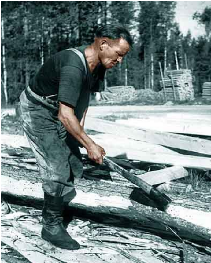
Kuva 46. Mies ja kirves veistävät Petäjävedellä hirsiiä talon seinäksi [48].
