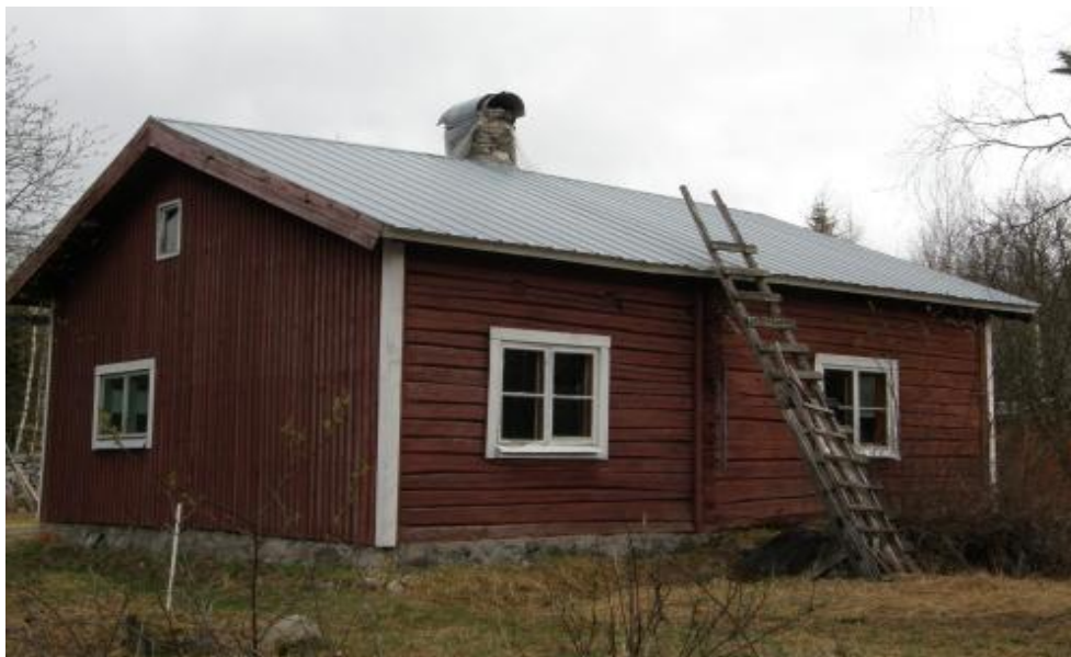
Kuva 5. 1880- luvulla rakennettu hirsirunkoinen mökki Kolilla.
