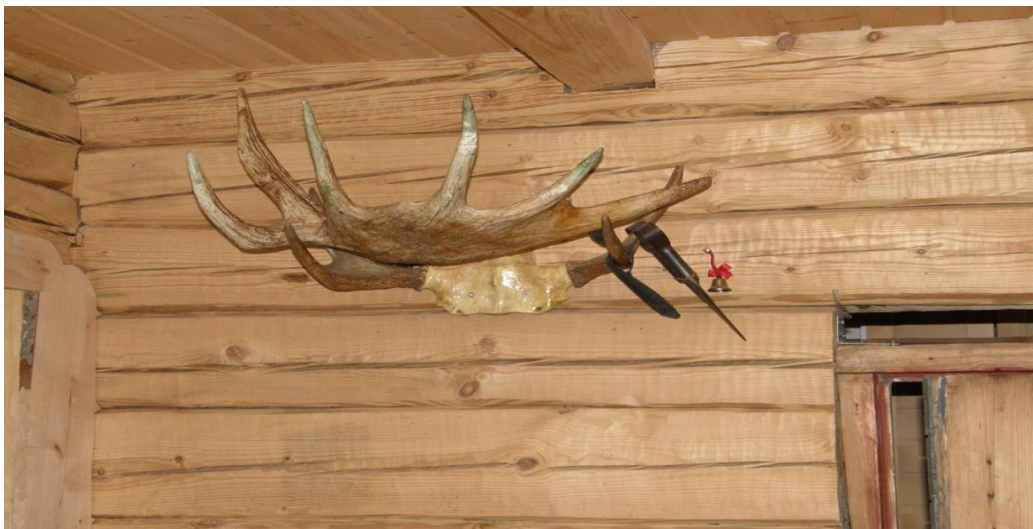
Kuva 12. Makuukamarista takahuoneeksi muutetun piiluttamattoman huoneen seinien tummentuneet hirret on hiottu kirkkaiksi pienellä lamellilaikalla.
