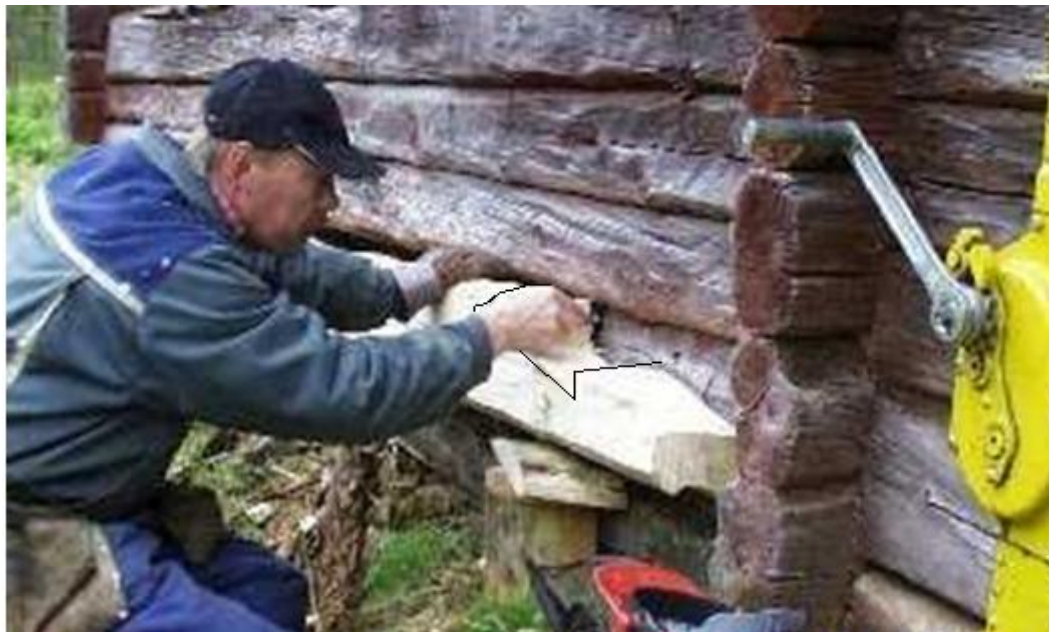
Kuva 32. Hirren liittäminen. Menossa hammaslapaliitoksen kopiointi vanhaan hirteen [38]
