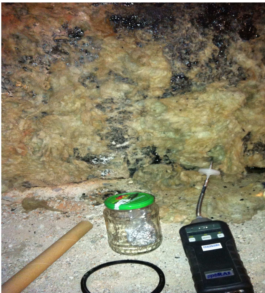
KUVA 10. Seinä, jossa kosteussivelynä käytetty kivihiilitervaa ja lämmöneristeenä mineraalivilla. Kuva: Henri Wennström.
