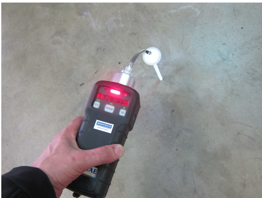
KUVA 3. Betonirakenteisen lattiarakenteen mittaus porareian kautta PID-laitteella öljy-yhdisteiden määrittämiseksi. Kuva: Jukka Huttunen.
