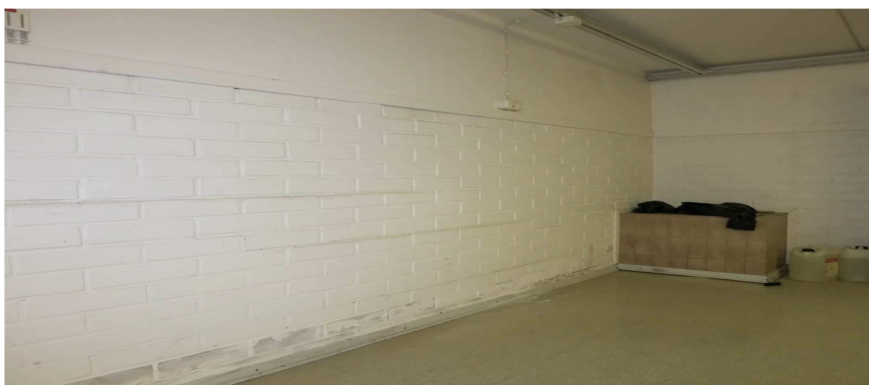
KUVA 15. Kuvassa mittapisteiden K5 ja K9 läheisyydessä oleva ulkoseinä, jossa havaittavissa kosteusvaurioita. Kuva: Jukka Huttunen.
