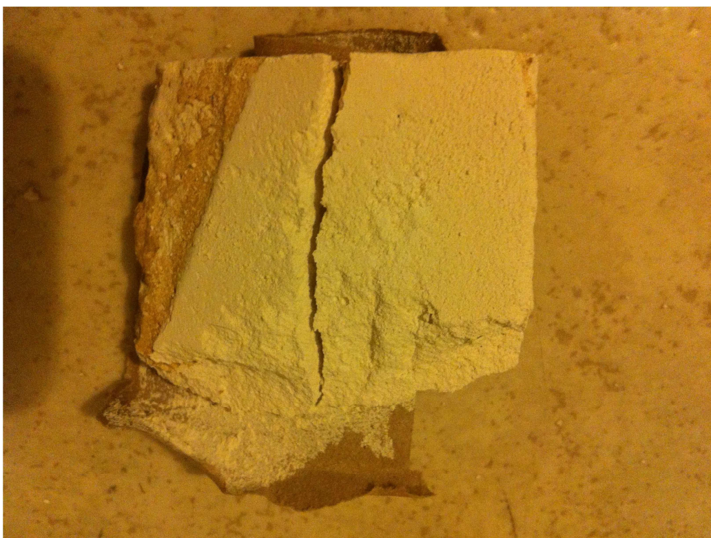
KUVA 11. Kosteudelle altistettu kipsilevy. Kuva: Henri Wennström.
