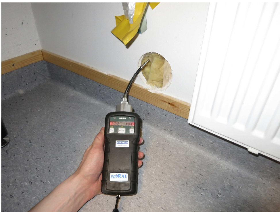
KUVA 13. Homeelta haisevan seinän eristeiden mittaus. Mittalukema kuvassa 2303ppb. Kuva: Jukka Huttunen.
