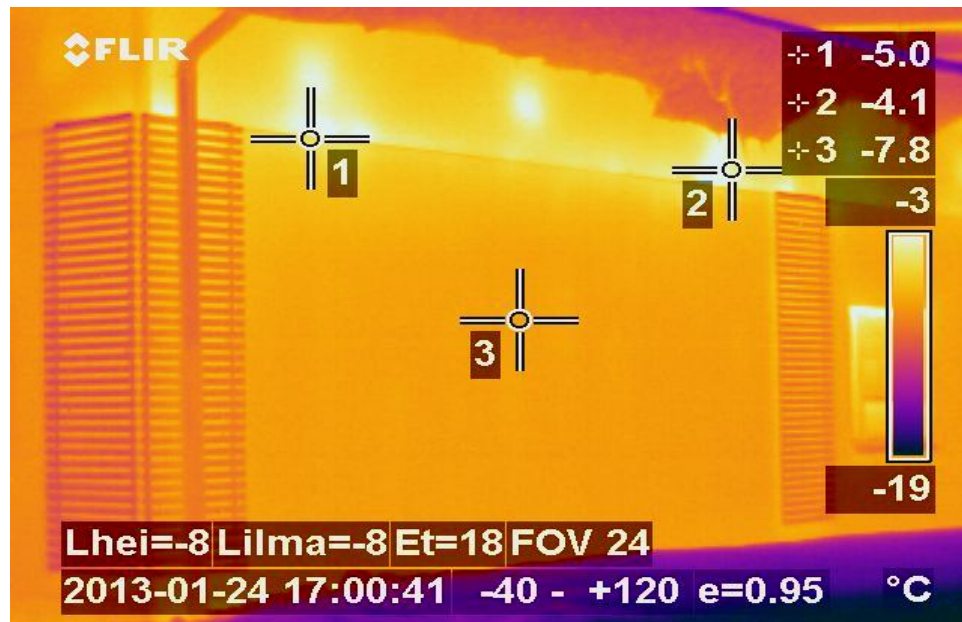
Kuvio 27. Lämpökamerakuva ulkoapäin rakennetyypistä US1.
