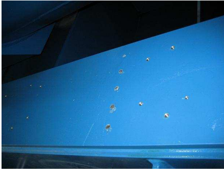
Kuva 7. Moduulille valmiiksi poratut reiät moottorialustalla.
