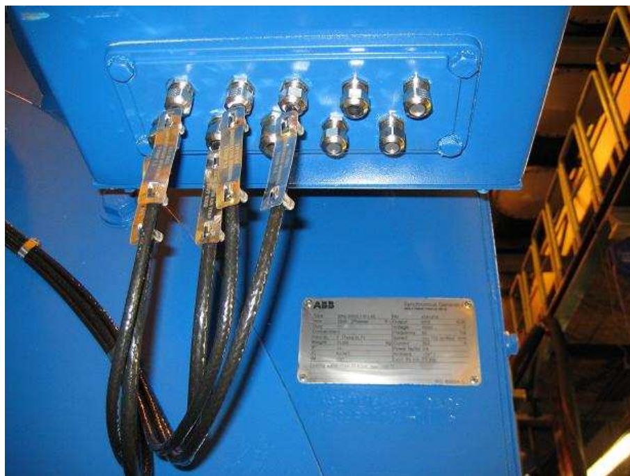
Kuva 16. Keskukselle menevät kaapelit sisäänvedettynä.
