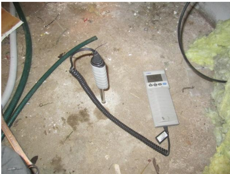
Kuva 8. Lattiarakenteen kosteusmittausta rakennekosteusmittarilla
