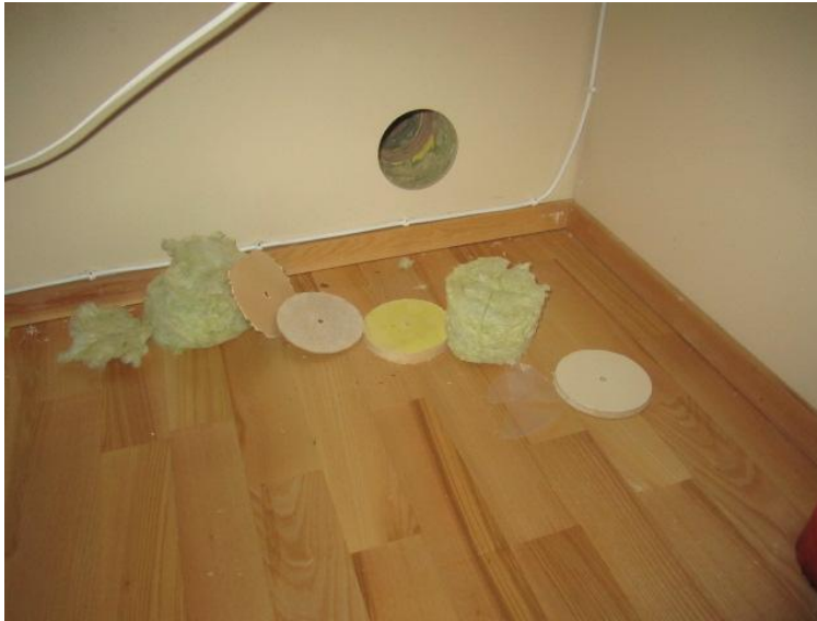
Kuva 7. Seinärakenteen tutkimusaukko
