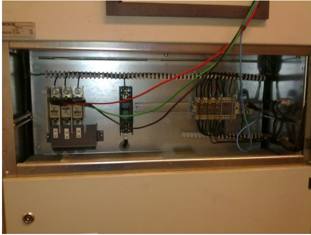
KUVA 23. Jännitteen ja nollajohtimen mittauspihdit kiinnitettyinä PK 2.1:een
