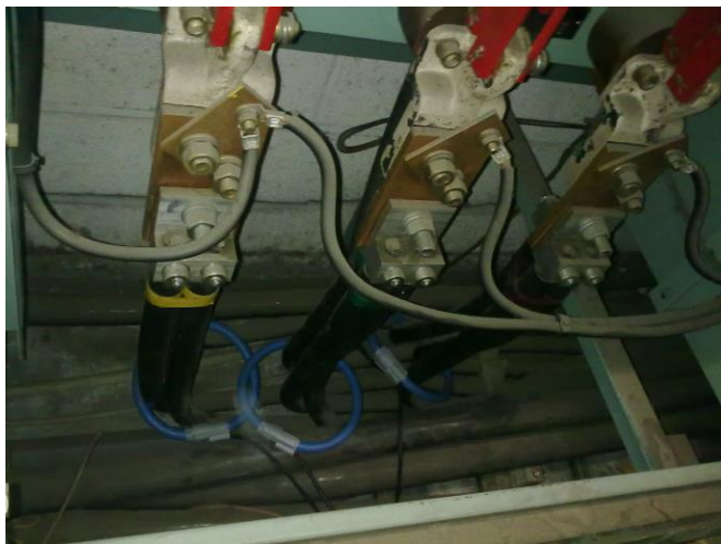
KUVA 24. Mittaus PK 3:n nousukaapeleista
