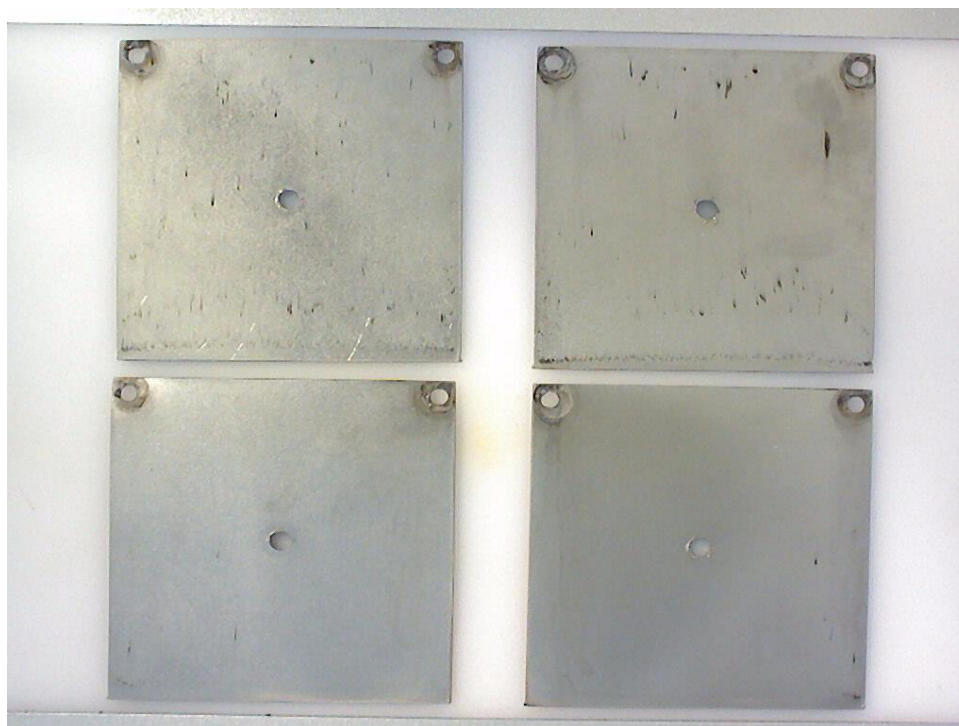
KUVA 6. S2V4, Ripustin 3, sisäpuoli.
