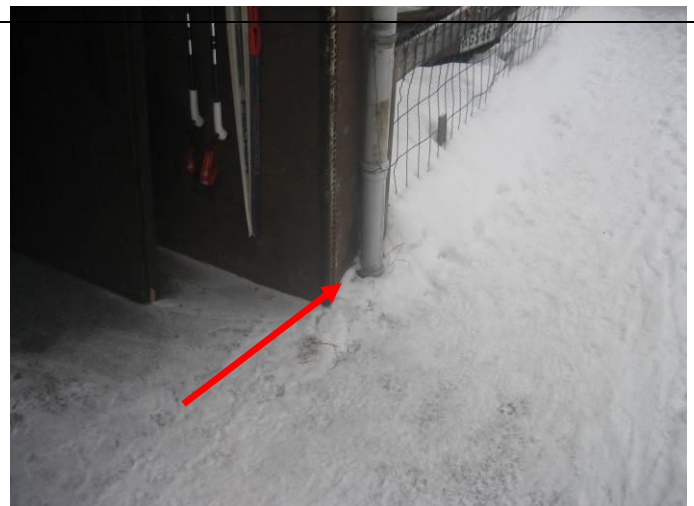
6. Kattovesien ohjausta parvekkeen alapuolella.
