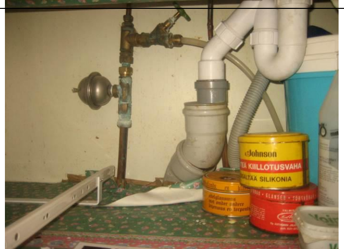
22. Allaskaappia. Vuotojälkiä vesiputkien liitoksissa.
