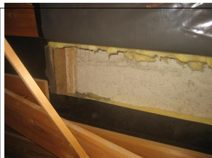
9. Rakenneavausta. Puurakenteessa ei silmämääräisesti havaittavia vaurioita.
