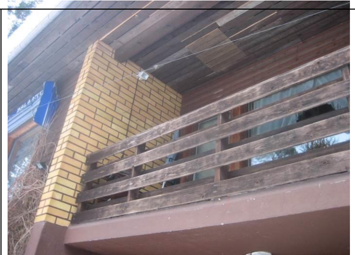
8. Julkisivua ja parvekettä. Kaide on huoltokäsittelyn tarpeessa.
