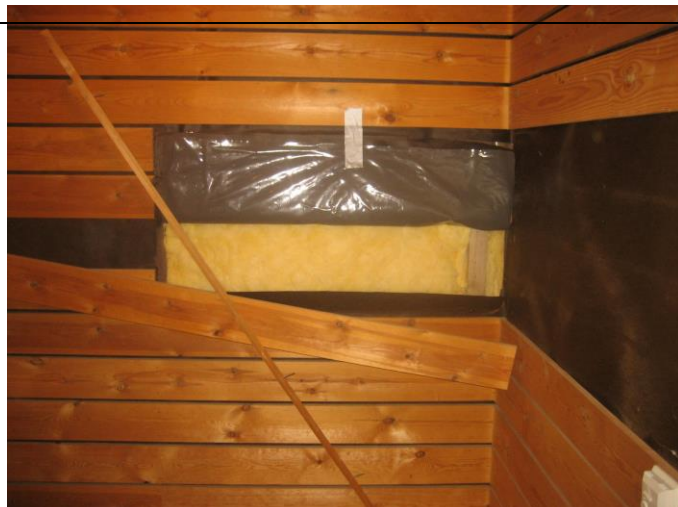
8. Seinältä poistettiin pintarakenteita. Eristevillassa ei silmämääräisesti vaurioita.
