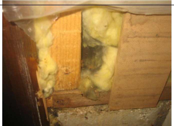
4. Ulkoseinän eristevilloissa on tummentumaa. Puurakenteissa ei havaittavissa vaurioita silmämääräisesti.
