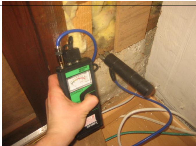
3. Ulkoseinän alasidepuussa ei ollut kosteutta rakenteen lämpimällä puolella.
