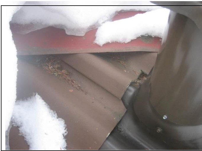
11. Vesikaton uusitun osan läpivientä ja aumapeltiä.
