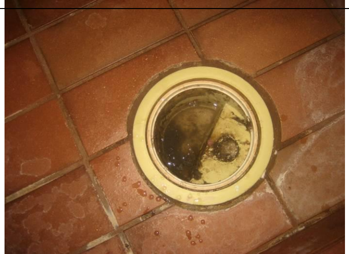
20. Suihkun lattiakaivo. Laattasaumoissa puutteita. Suihkua käytetty alle 24 h ennen tarkastusta.
