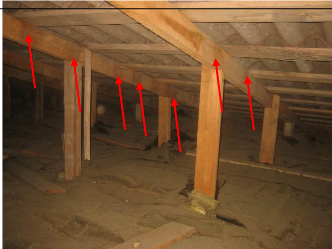
13. Yläpohjatilaa alkuperäisellä vesikaton osalla. Ei aluskatetta. Nuolien kärkien osoittamissa kohdissa on kosteusjälkiä.
