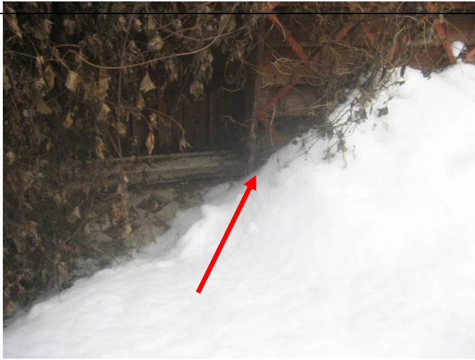
1. Valesokkelirakenne, jonka takana puurungon alaosat ja lämmöneristeet alkavat läheltä maanpinnan tasoa. Ulkoseinillä kasvaa lisäksi runsaasti kasvillisuutta.
