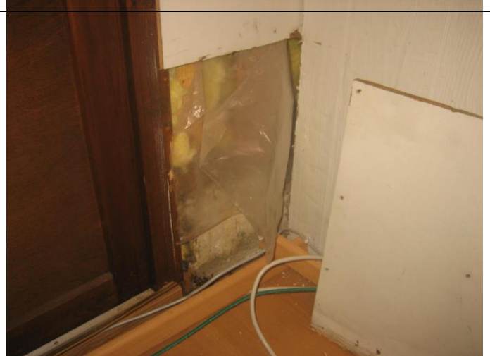
2. Rakenneavaus. Havaittiin, että rakenne ei olekkaan varsinainen valesokkelirakenne.
