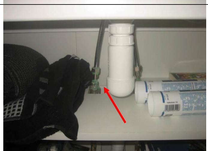
18. Vanhoja vuotojälkiä vesiputkien liitoksissa. Ei vuotoa tarkastushetkellä.
