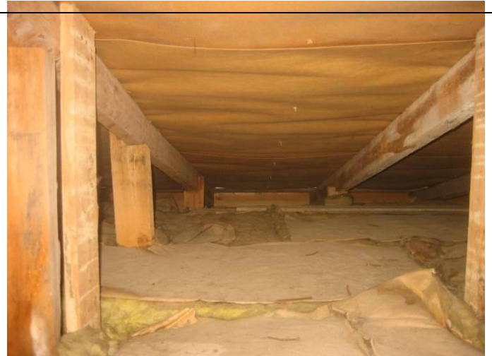
14. Yläpohjatilaa uusitulla veikatton osalla. Aluskate on asennettu.
