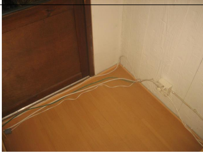
1. Toimisto/takkahuoneen nurkka, johon rakenneavaus tehtiin.
