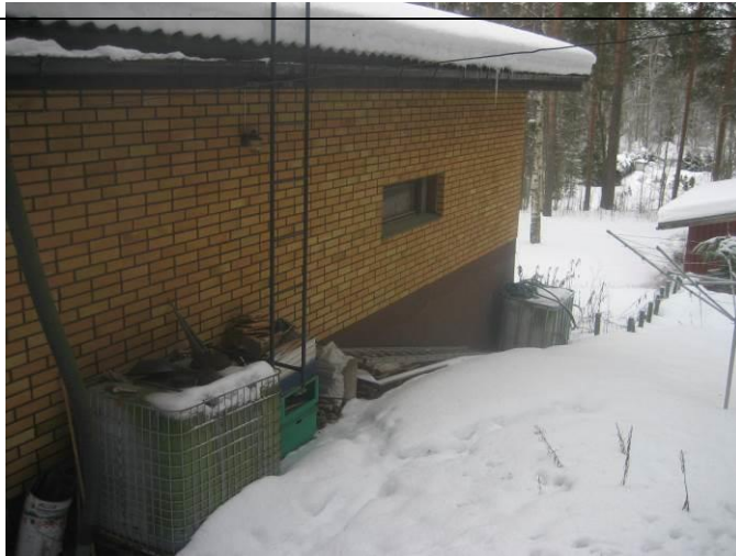
3. Rakennuksen vierustaa talon pohjoispäädystä. Seinustalle kasattu ylimääräistä palokuormaa.
