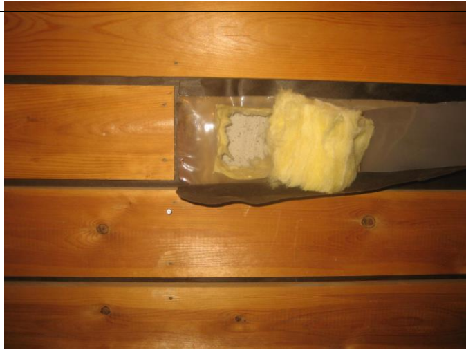
11. Pienempi rakenneavaus noin 1,2 metrin korkeudelta lattiatasosta.
