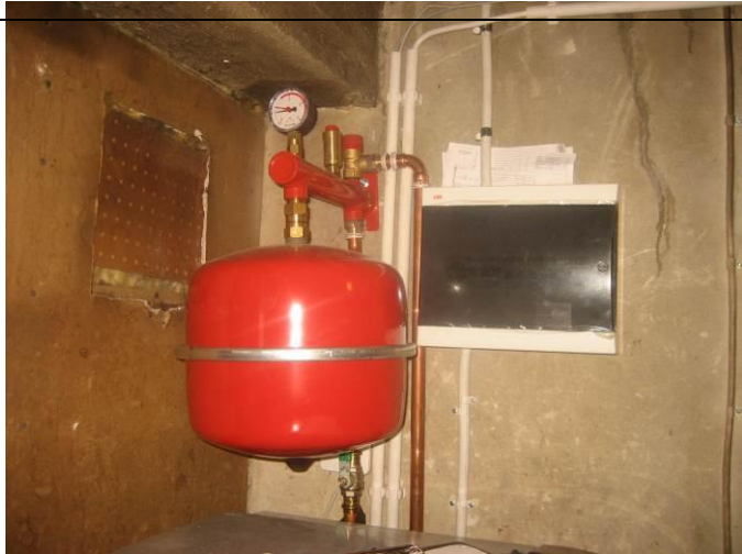
30. Maalämpöjärjestelmän sulakkeita ja paisuntasäiliö
