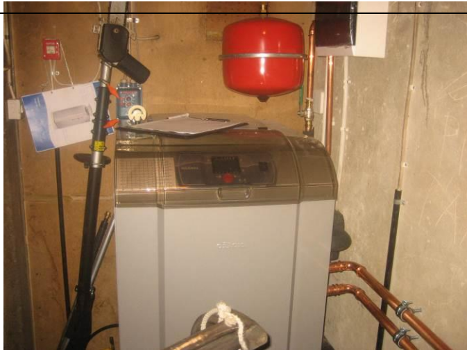
27. Maalämpöpumppu ja paisuntasäiliö teknisessä tilassa.
