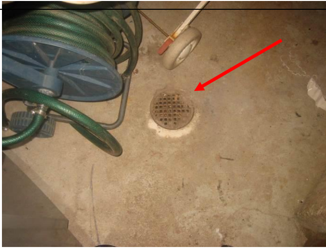
23. Teknisen tilan sulkematon lattiakaivo.
