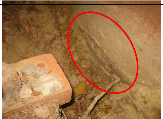
2. Perusmuurin kosteuseristyksenä toimiva rakennusmuovi. Havainto koiran kaivamasta kuopasta koirankopin takaa.
