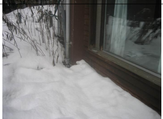
4. Rakennuksen seinustaa lännen suuntaan. Seinän puuverhoillulla osalla on valesokkelirakenne. Seinustalle kasatut lumet aiheuttavat keväällä suuren kosteusrasituksen ulkoseinärakenteille.
