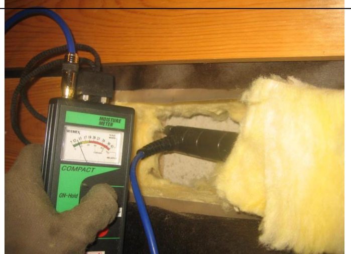
12. Puukoolauksen kosteus noin 13 p-% -> Ei vaurioita puurakennetta.
