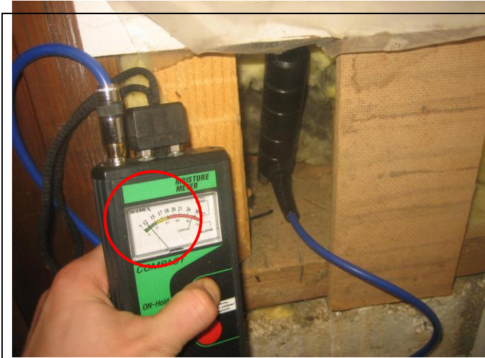
5. Ulkoseinän puurungon alasidepuun yläpinnan kosteus 12 %.
