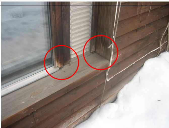
9. Epätiiveyttä ja puun pehmenemistä ikkunoissa
