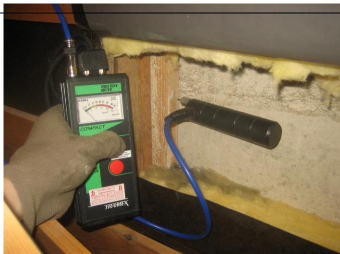
10. Puun kosteus rakenneavauksen kohdalla noin 8 p-%.
