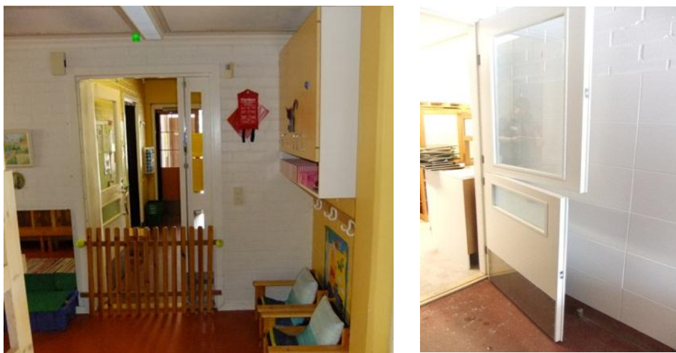
Kuva 19 ja 20. Vesikirppujen eteistilat ennen korjausta ja märkäeteisen ovi muokkauksen jälkeen (Kuvat: Armi Mäkinen).
