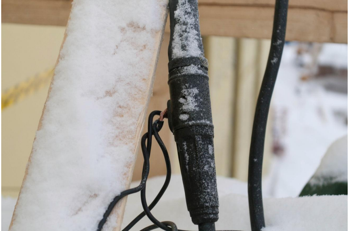
Kuva 22. Sähköenergian välitys runkokaapeleilta lämmityslankaan. (Kuva: Juha Uusitalo)
