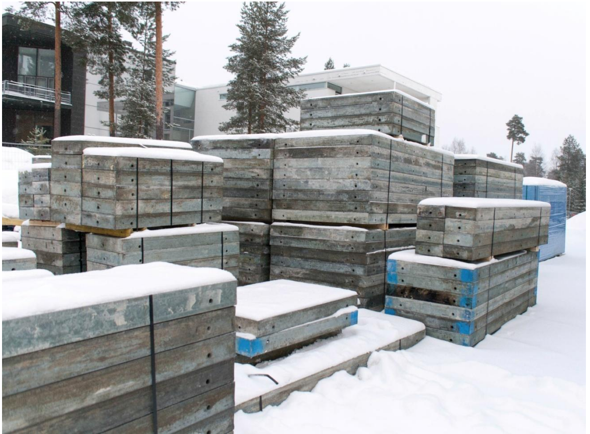
Kuva 3. Järjestelmämuottien säilytys työmaalla. (Kuva: Juha Uusitalo)
