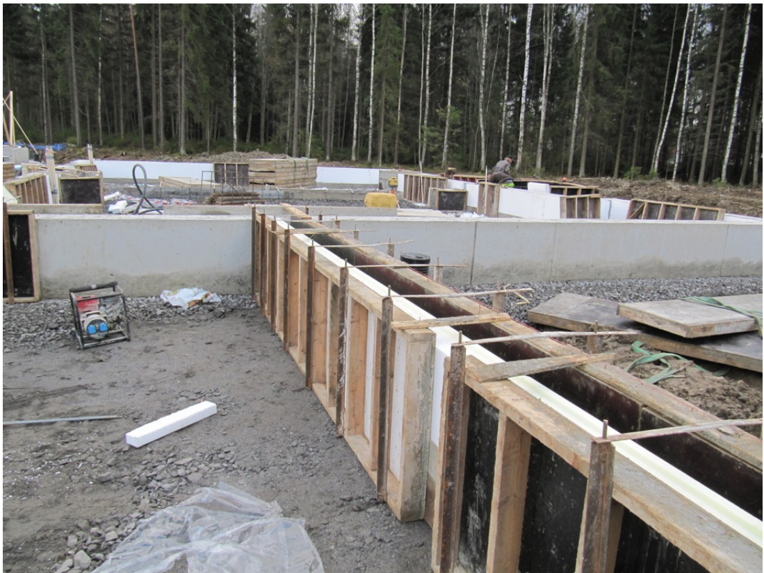
Kuva 1. Muotittettua ja valmista perusmuuria.
