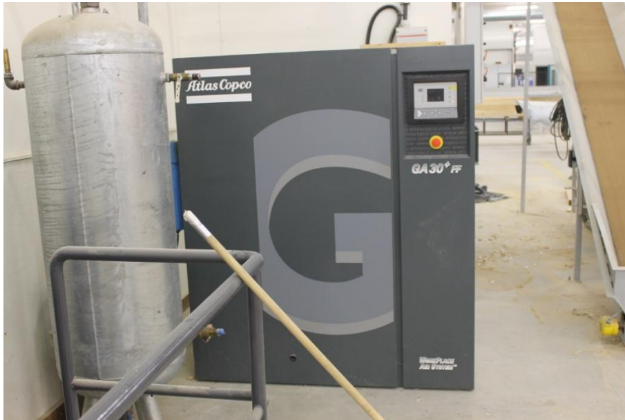
Kuva 29. Ruuvikompressori Kontiotuote Oy
