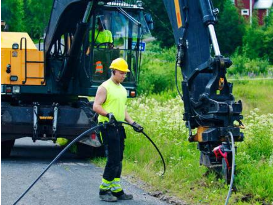
KUVA 2. Kaapelin aurausta maantielaitaan
