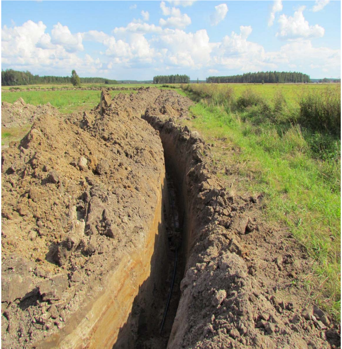
KUVA 1. Kaapelioja kaivamalla 40cm kauhalla vapaaseen maahan
