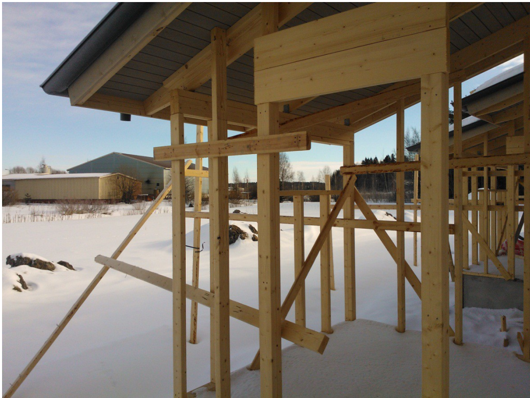
Kuva . Paikalla rakennettu varaston runko.
