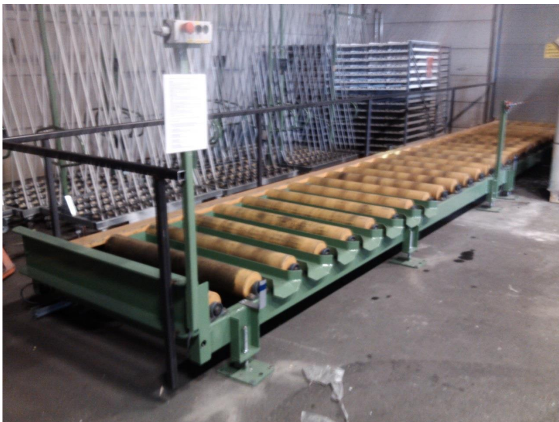
KUVA 3. Kuljettimen suojaustekniset lisälaitteet (valokuva Juuso Kaplas.)
