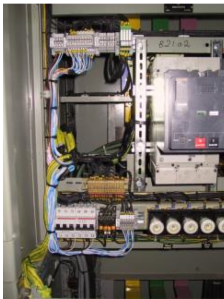
Kuva 16. Lisätyt komponentit ja riviliittimet jakelutaulussa
