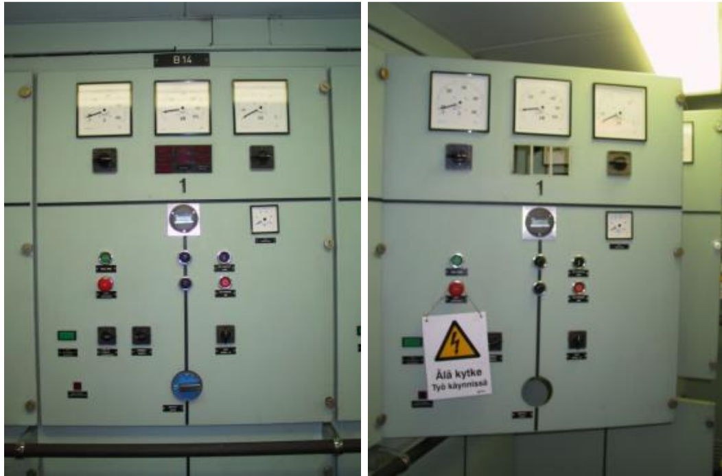
Kuva 17. Hälytysmerkkilamppujen purku
