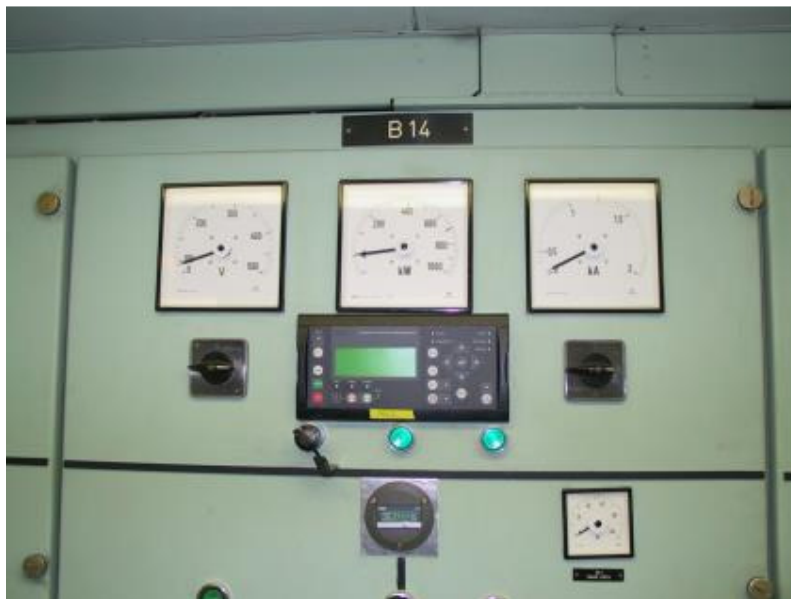
Kuva 18. Operointipaneelin, käynninestokytkimen ja painikkeiden asennus
