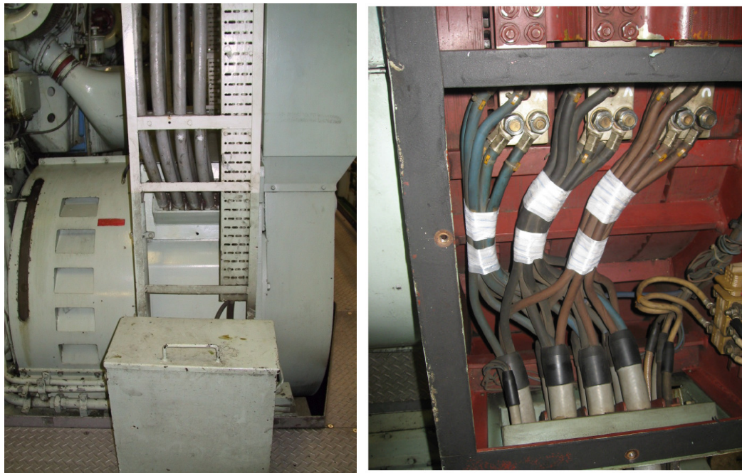
Kuva 3. Apugeneraattorin kaapelointi ja kytkentä (MDA Service, 2012)
