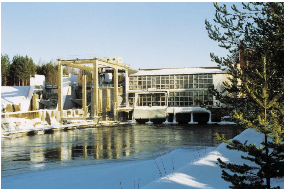
Kuva 2. Pankkosken vesivoimalaitos talvella (Kemijoki Oy:n WWW-sivut 2013, hakupäivä 13.2.2013)
