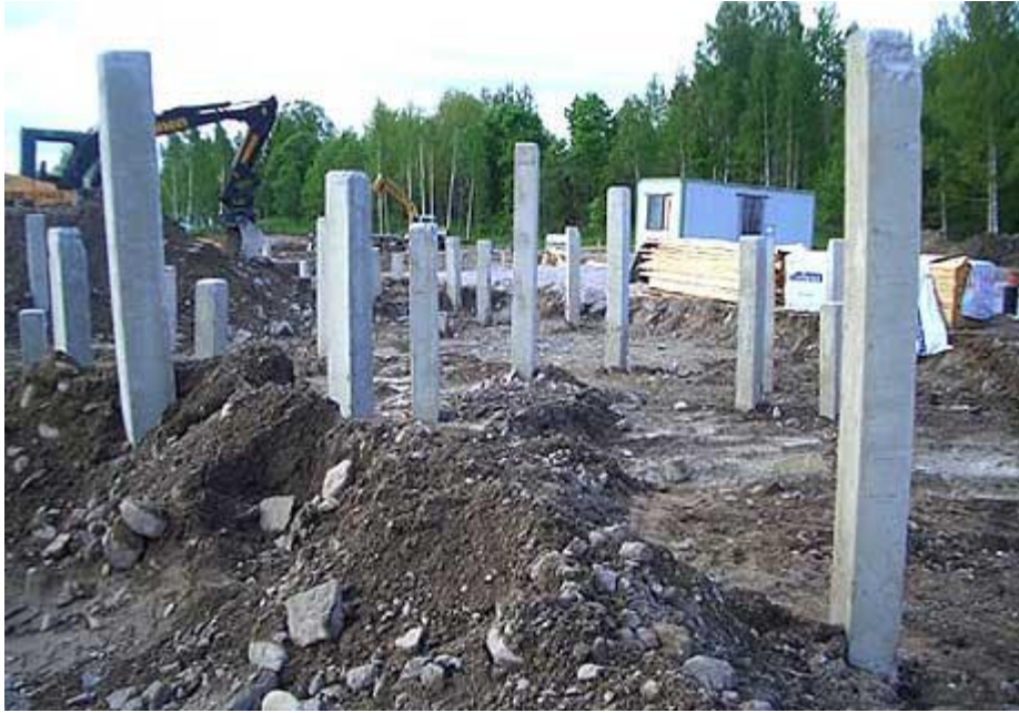
Kuva 22 Raudoitettu betonipaaluperustus (Rakentaja internetsivut, Hakupäivä 22.3.2013)
