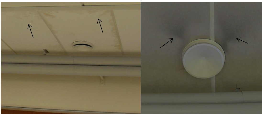
Figur 6 och 7. Missfärgade akustikskivor i taket, den vänstra är missfärgad troligen av fukt och den högra av orenheter i tilluftskanalerna.
