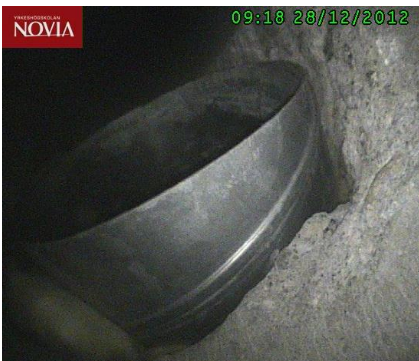
Figur 9. Anslutningsrör av plåt.
