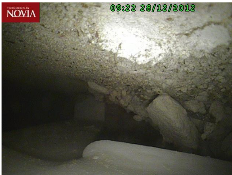
Figur10. Skräp inuti kanalen i form av betong rester och ett plastlock.
