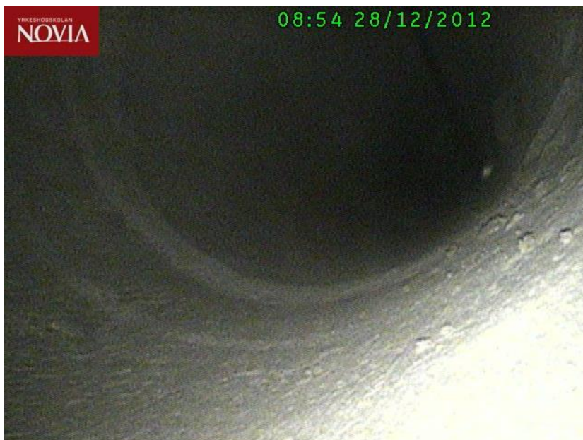
Figur 8. Inuti ventilationskanalen i ett klassrum, syns det att ytan i kanalen är av betong.
