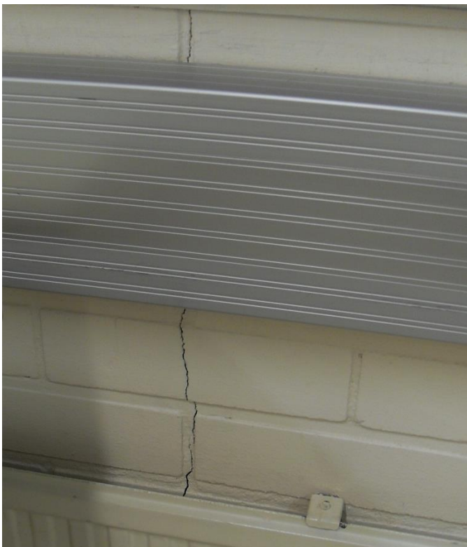
Figur 5. Sprickor i yttervägg under fönster.
