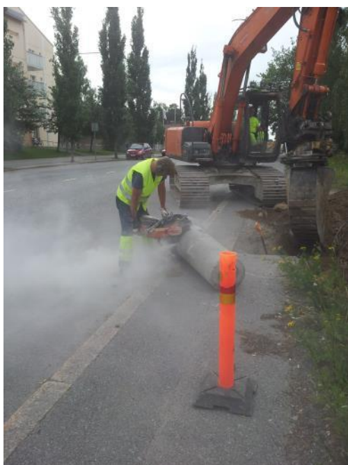
Figur 18. Avskärning med diamantsåg av fundament.
