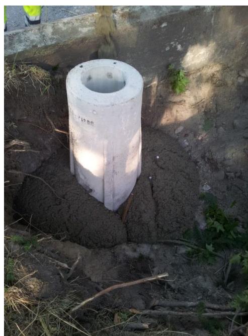
Figur 19. Armeringsjärn borrarades ner i berggrunden för en övertäckande gjutning med betong.
