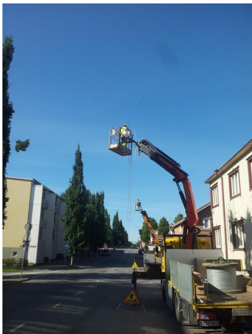
Figur 26. Vajermontering med två bilkranar för att effektivisera monteringen.
