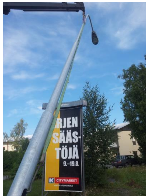
Figur 27. Kranlyftning av markmonterad belysningsstolpe.
