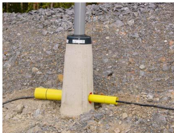
Figur 21. Kablar skyddades med skyddsror. Ett 100 mm skyddsror.
