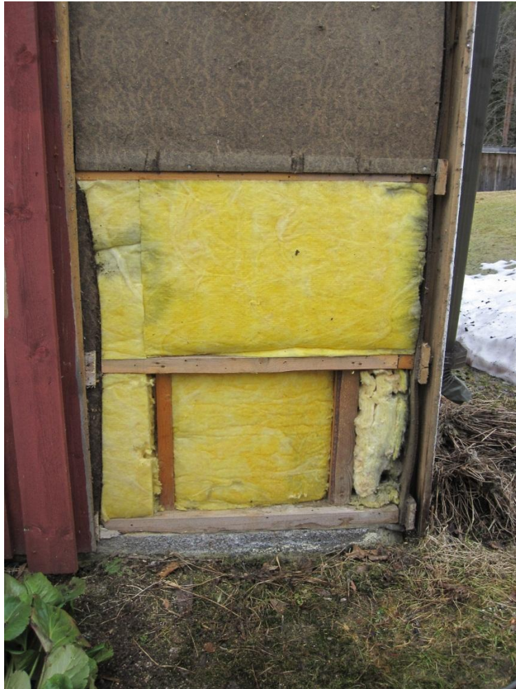
Kuva 3. Rakenne avattuna ulkoseinän kohdalta.
