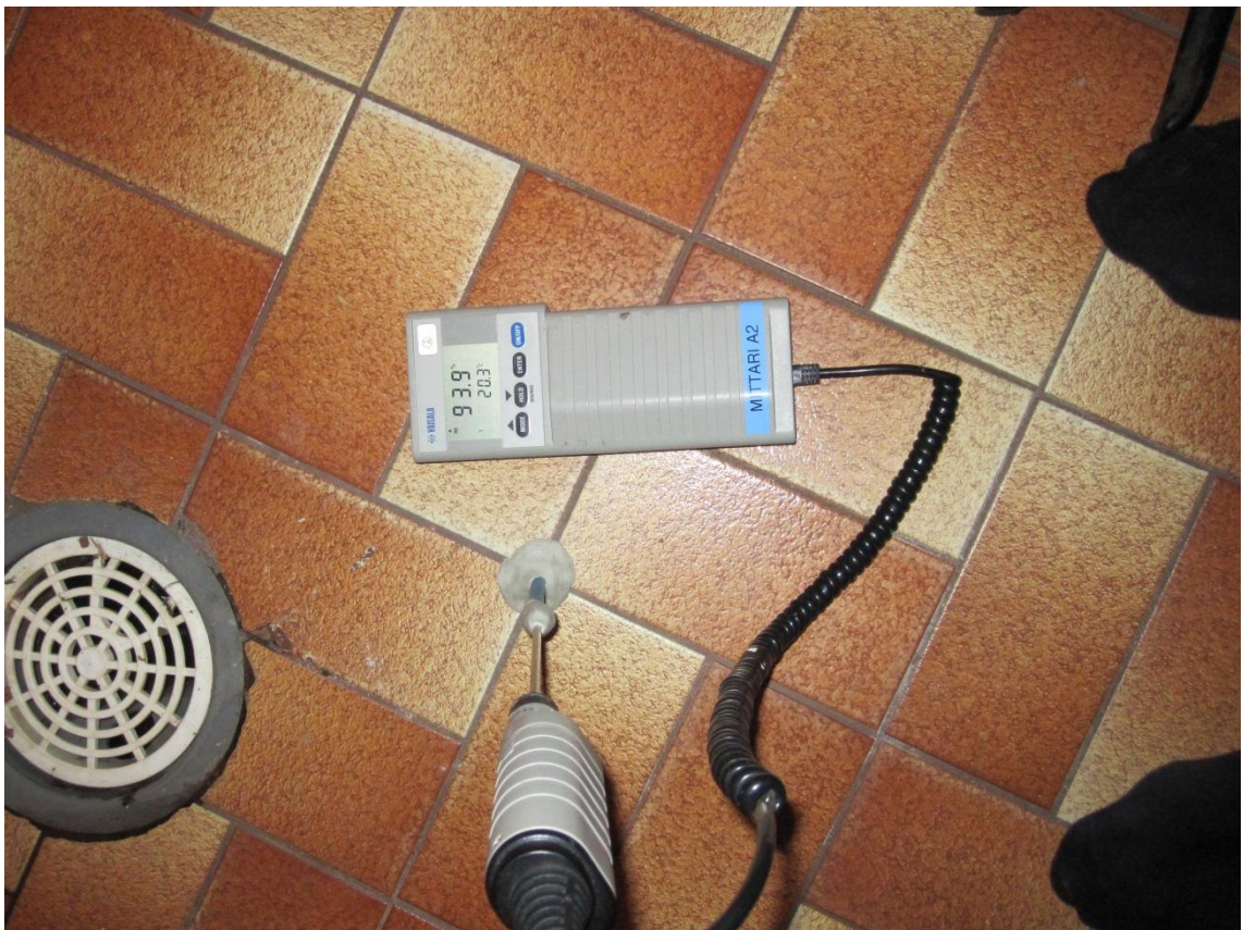
Kuva 2. Kosteuden mittaaminen betonilaatasta.
