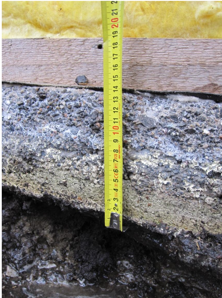
Kuva 5. Matala perustus kallion kohdalla.
