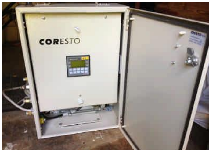
Kuva 13. MoCo DP PLC-keskus
