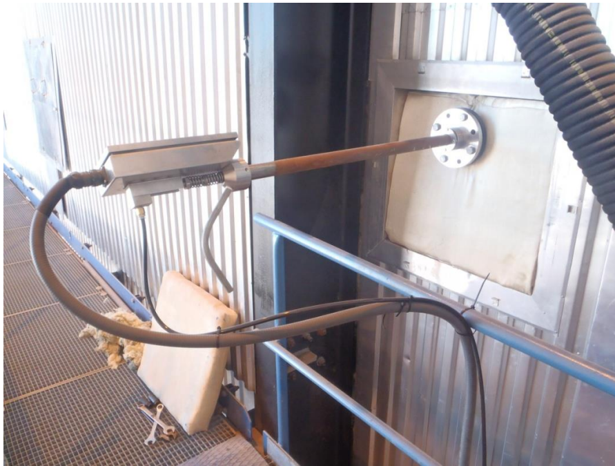
Kuva 27. Anturi asennettuna koepalat seinämän lähellä
