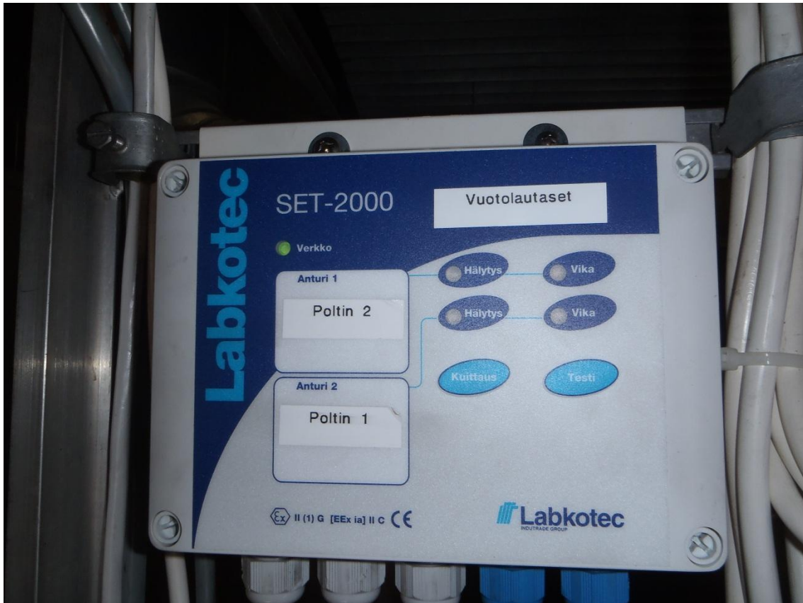
KUVA 12. Labkotec SET-2000 -keskusosa asennettuna
