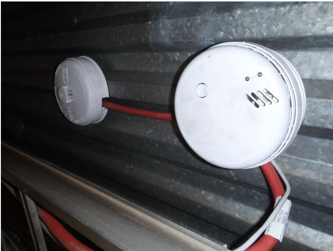
KUVA 11. Lämpöilmaisimien ja optinen savuilmaisin asennettuna
