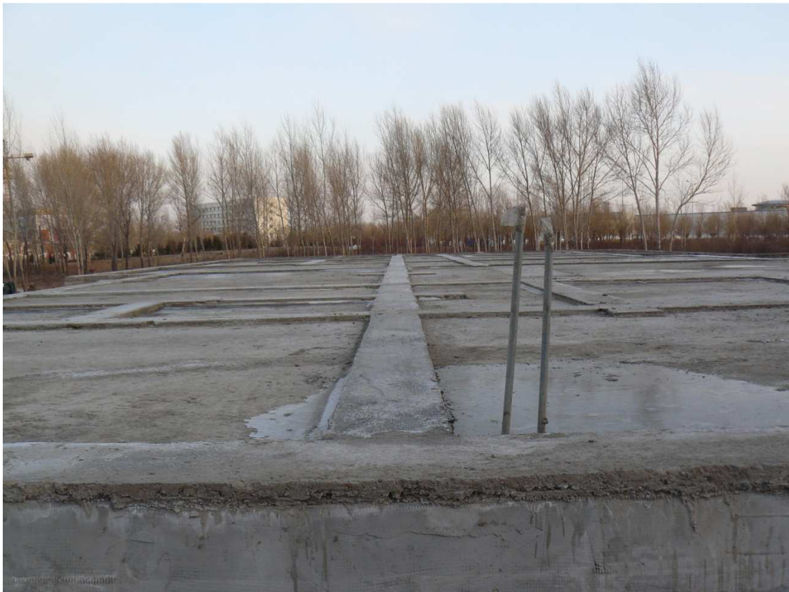
KUVA 3. Talon 1 perustukset (20 x 35 m) oli valettu edellisenä syksynä
