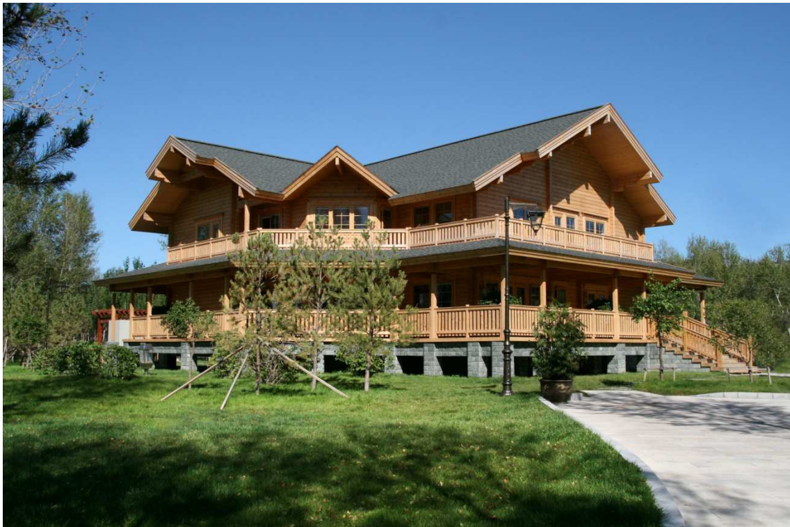
KUVA 15. Talo 2 valmiina ulkoa
