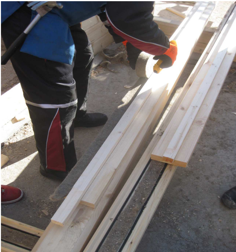
KUVA 6. Karapuiden asennus opetettiin kädestä pitäen kahdelle työmiehelle
