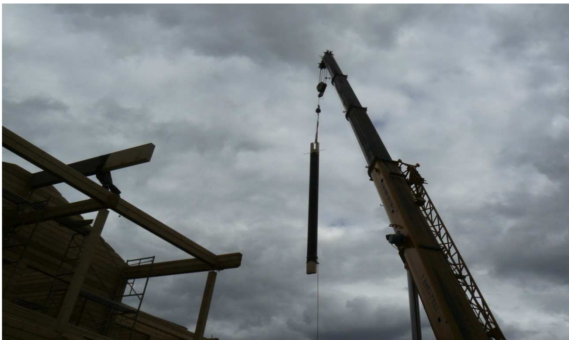
KUVA 8. Nosturi vieraili työmaalla projektin aikana kolme kertaa nostamassa liimapalkkeja
