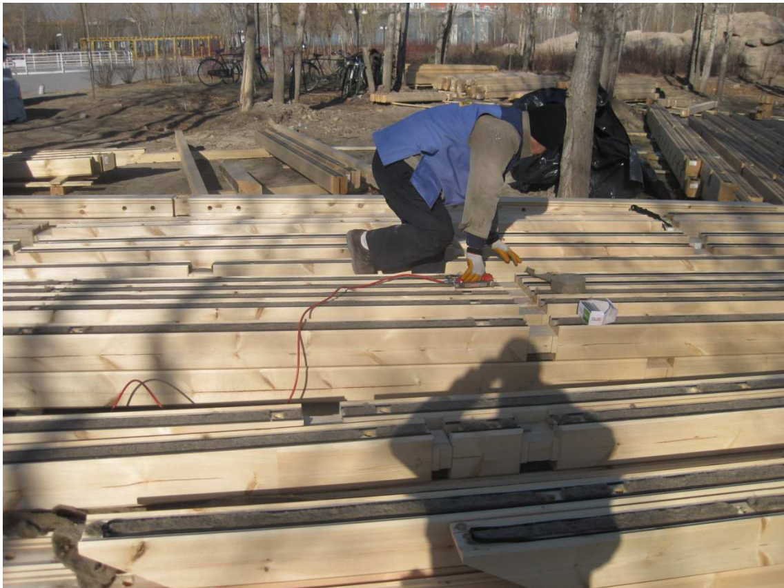
KUVA 5. Paikallinen asentamassa pellavaa ja EPDM-kumitiivistettä valmiiksi hirsiin
