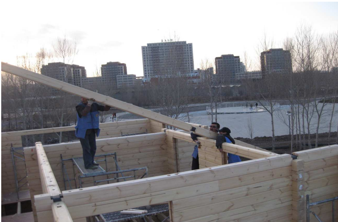
KUVA 7. Yhdeksän metrin hirsi nousee 6,5 metrin korkeuteen lautojen ja keppien avustamana maan pinnalta
