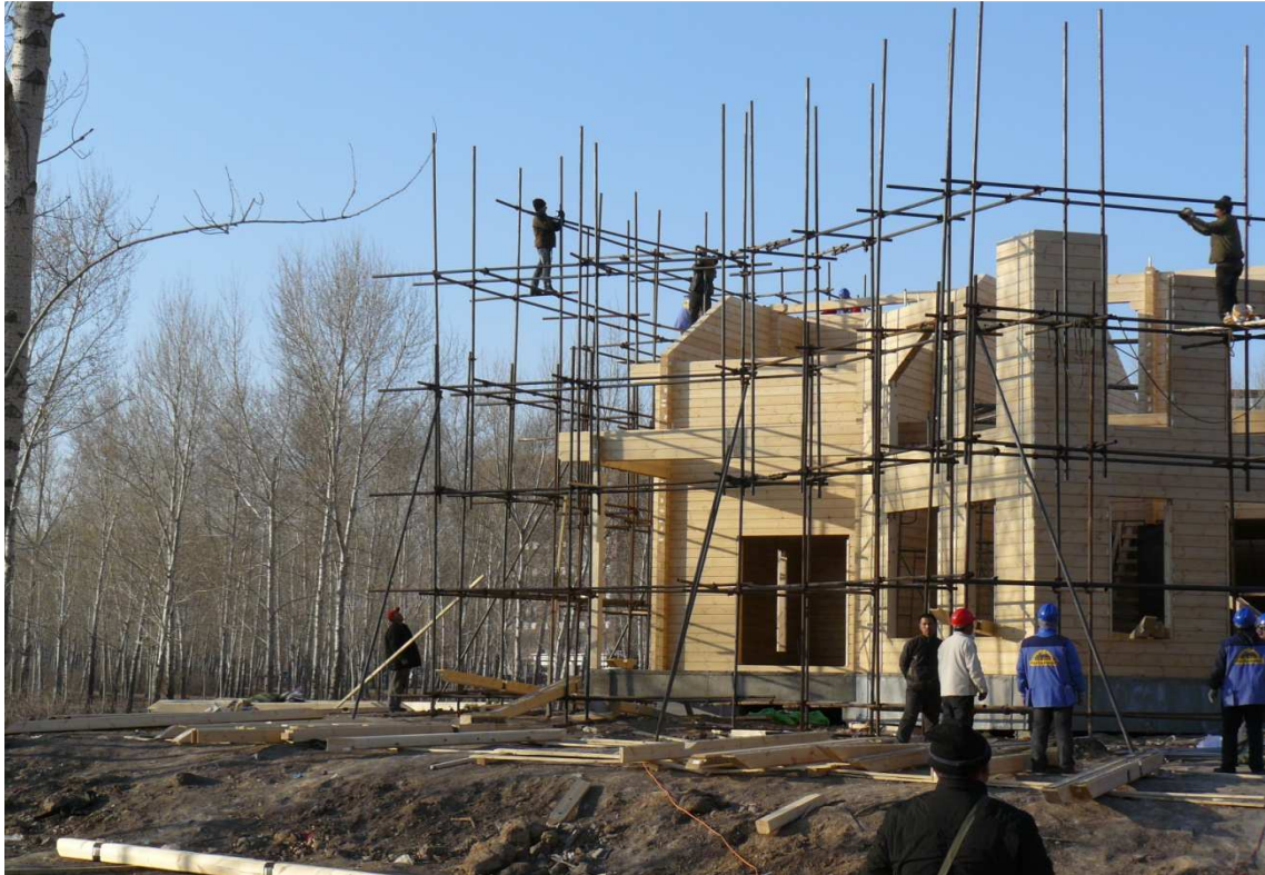
KUVA 12. Paikallinen telinerakentajaporukka rakentamassa telineitä maalareita varten
