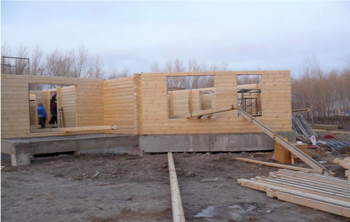
KUVA 4. Pystytysporukka oli juuri saanut asennettua hirret aukkojen ylitse ja hirret oli levitelty ympäri rakennusta
