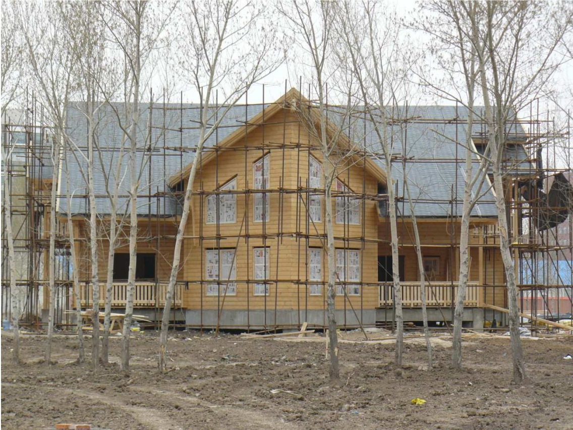
KUVA 11. Talo 3 valmiina pintakäsiteltäväksi
