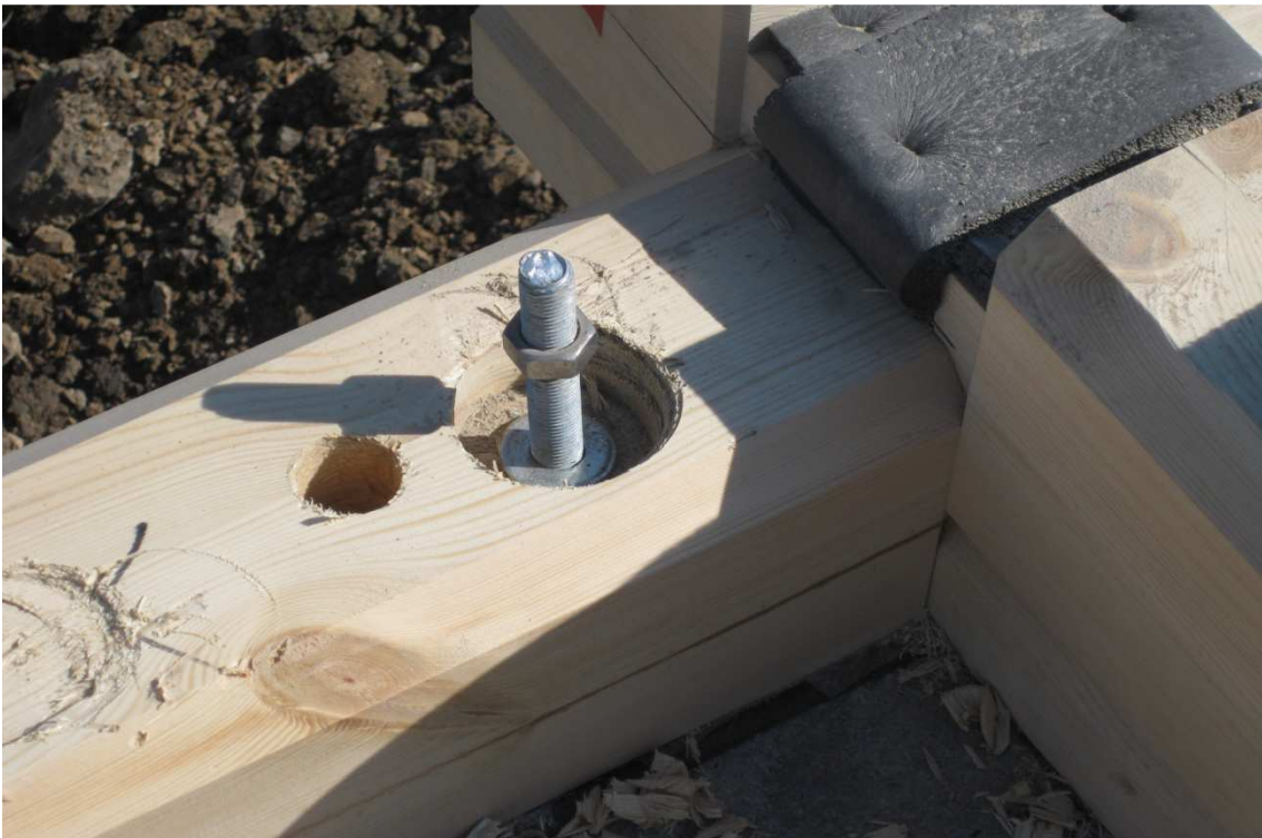
KUVA 10. Kehyksen ankkurointi perustuksiin
