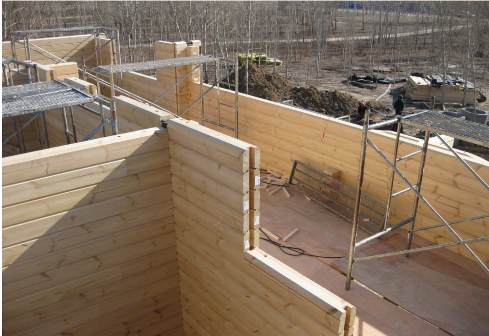
KUVA 13. Talon 2 välipohjaan asennettiin vanerit kulkemisen ”helpottamiseksi”
