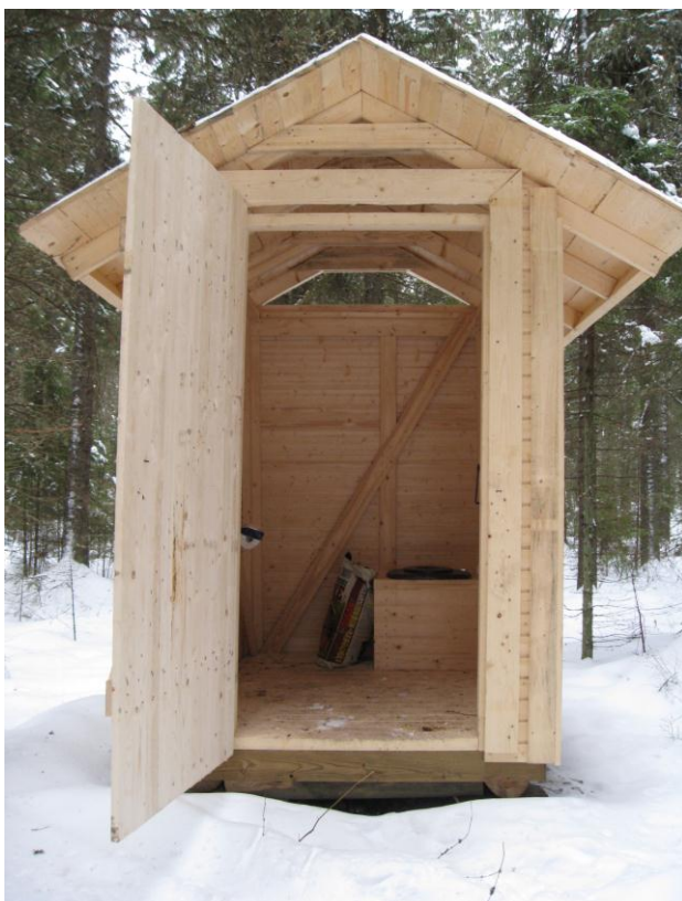
Kuva 4. Taukopaikan esteetön puucee
