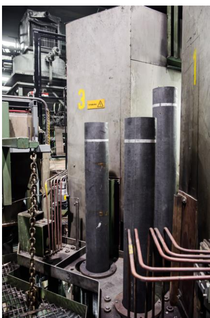
Kuva 16. Elektrodisauvat nykyisessä tukirakenteessa.
