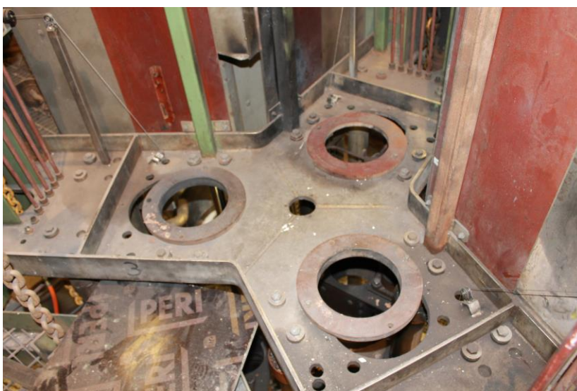
Kuva 13. Elektrodien tukirakenne ja niiden ohjausrenkaat.
