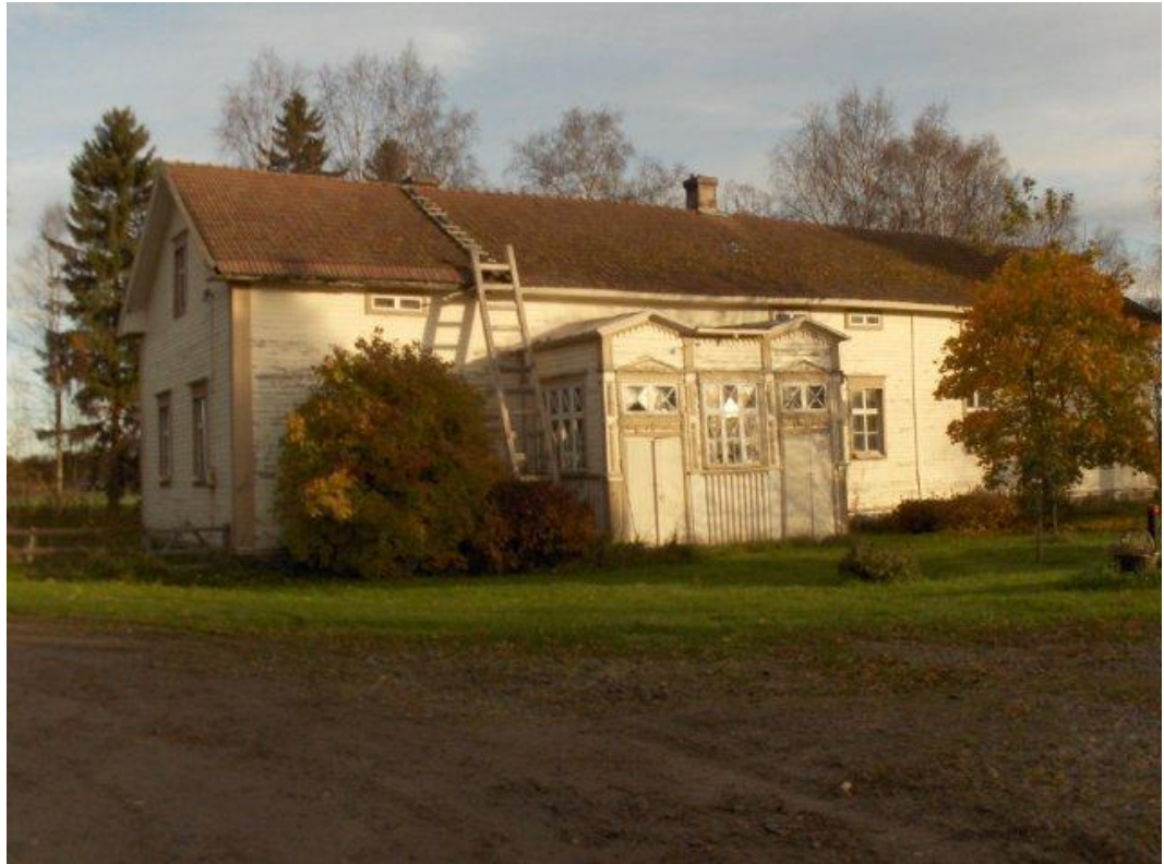
Kuva 6. Rämeen tilan vanha päärakennus.
