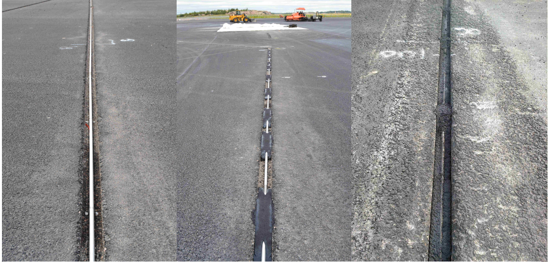
Kuva 9. Rosteriputken peittämisen eri vaiheet
