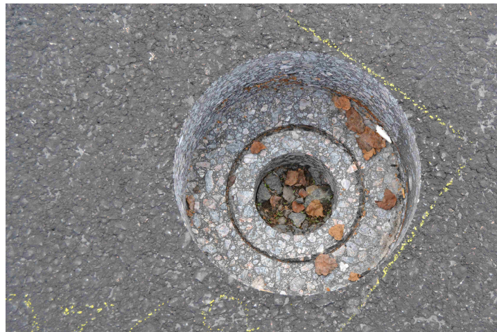
Kuva 12. Valaisinta varten porattu reikä
