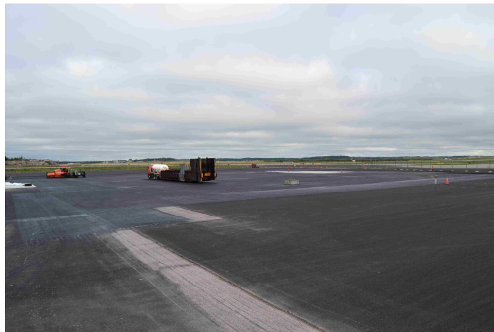
Kuva 7. Yleiskuva 04R etäjäänpoistoalueen asfaltoinnista
