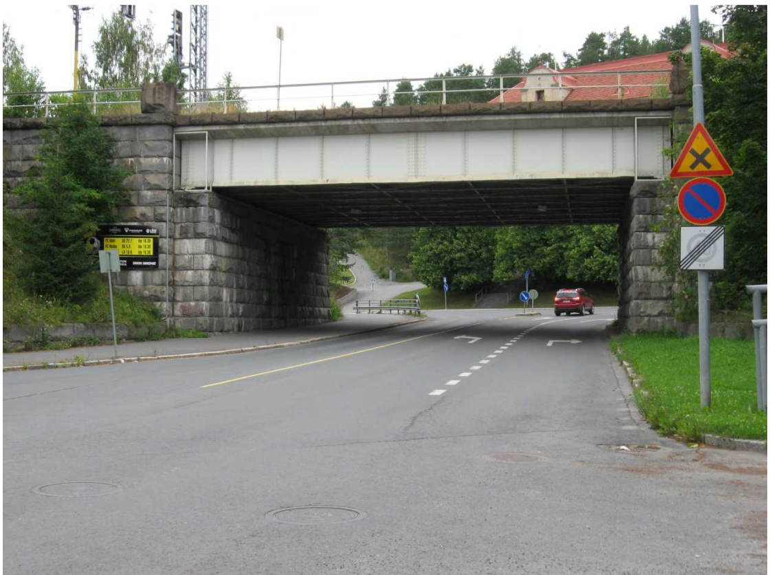
Kuva 1 Maaherrankadun alikulku Kuva Sylvi Alakiikonen 2012
