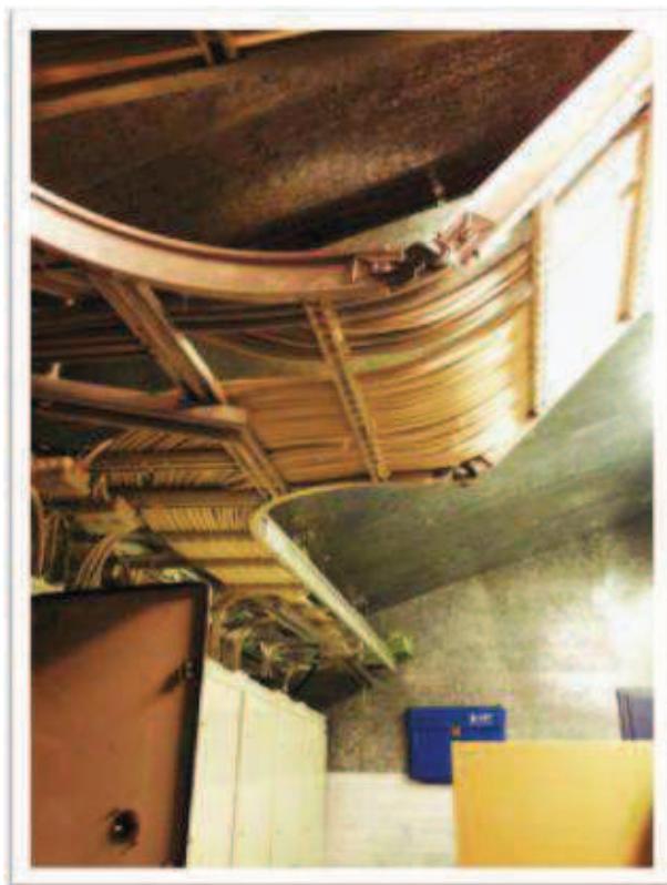
Kuva 3. Kaapelihyllyasennus
