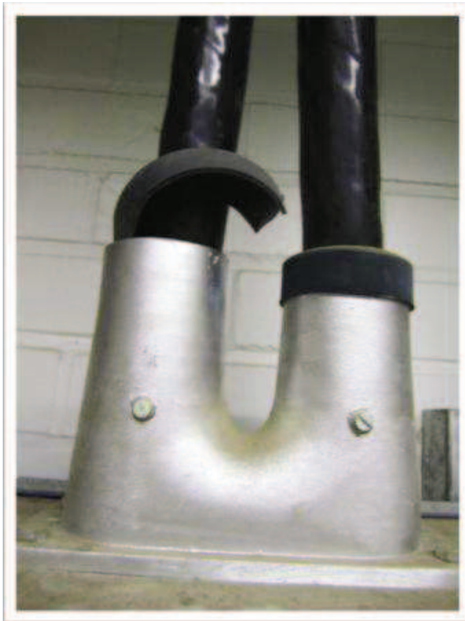
Kuva 4. Irronnut tiiviste
