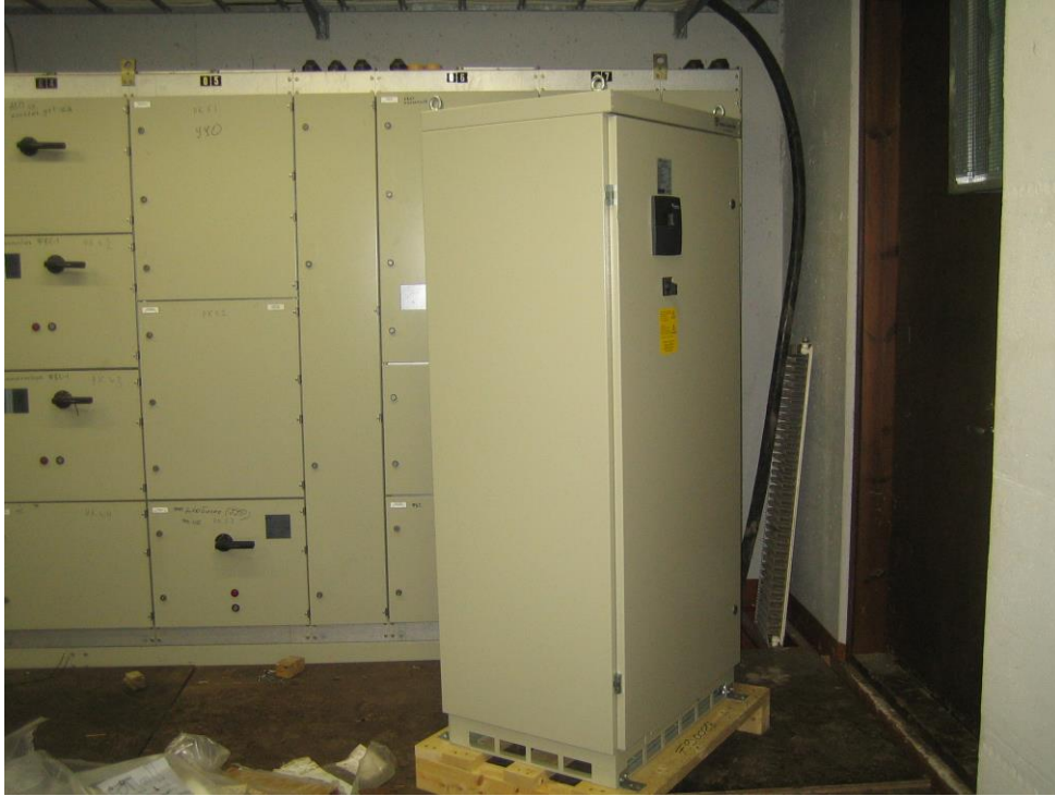
Kuva 9. Kompensointijärjestelmän asennus alkamassa
