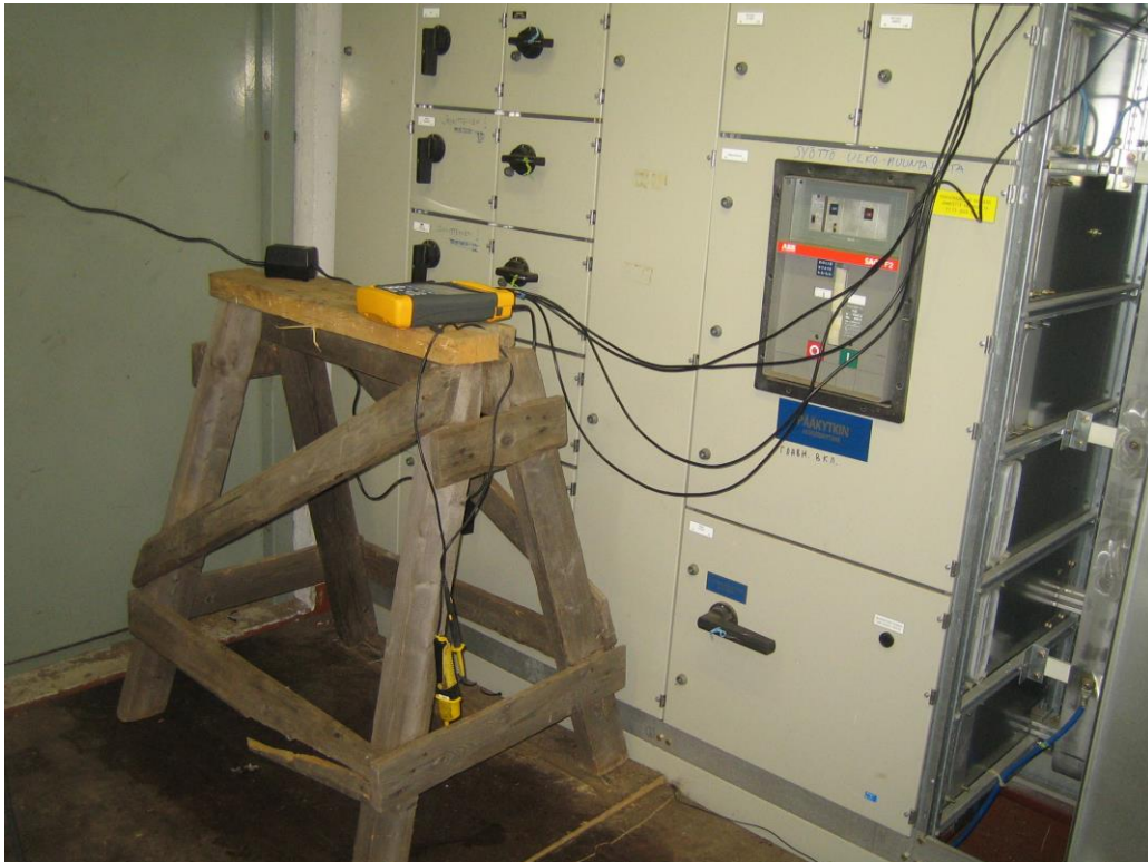
Kuva 6. Mittalaitteen virtamittausmuuntajien asentaminen nousukaapeliin
