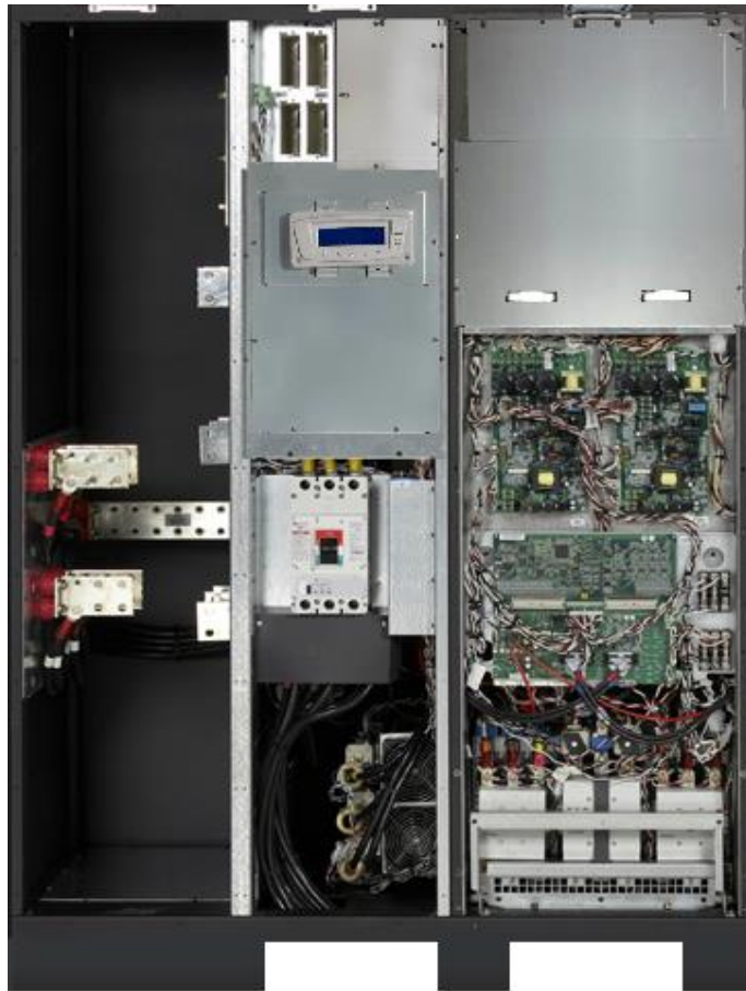
Kuva 5. Eaton 9395 275kVA UPS -laite
