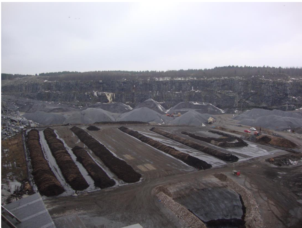
Kuvio 2. Stormossenin kompostointikenttä, jossa kompostoidaan bioreaktoreiden mädätysjäännöksiä.
