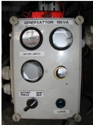
KUVA 28. Dieselmoottorin hälytys- ja mittaripaneeli
