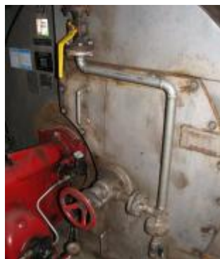
KUVA 9. Hörypuhallusventtiilit
