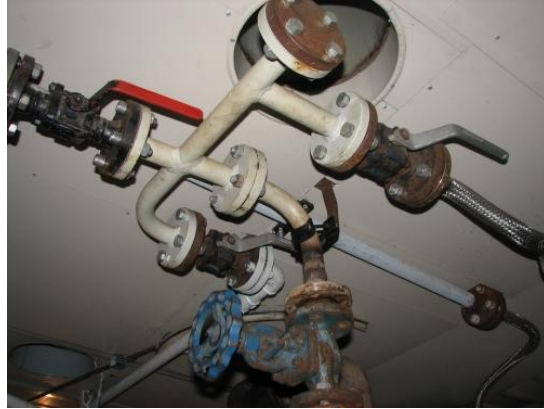
KUVA 5. Syöttövesiventtiilit
