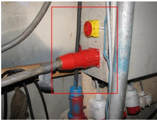
KUVA 31. Laivan sähköverkon virransyöttöpistoke ja päävirtakatkasija
