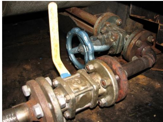
KUVA 8. Pohjapuhallusventtiilit
