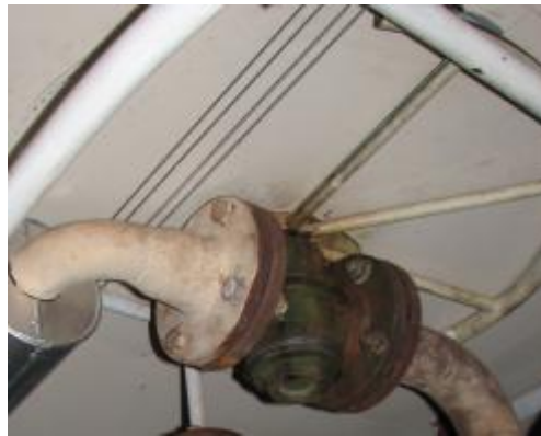
KUVA 4. Höyryn pääventtiili
