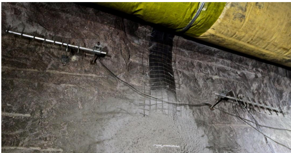
Kuva 11. Kuvassa asennettu salaoja Ruoholahden työmaalla. Ylhäällä näkyy tuuletusrähti ja seinällä antennit. Salaojaa on alhaalta jo osin suojabetonoitu. Kuva: Timo Kotineva
