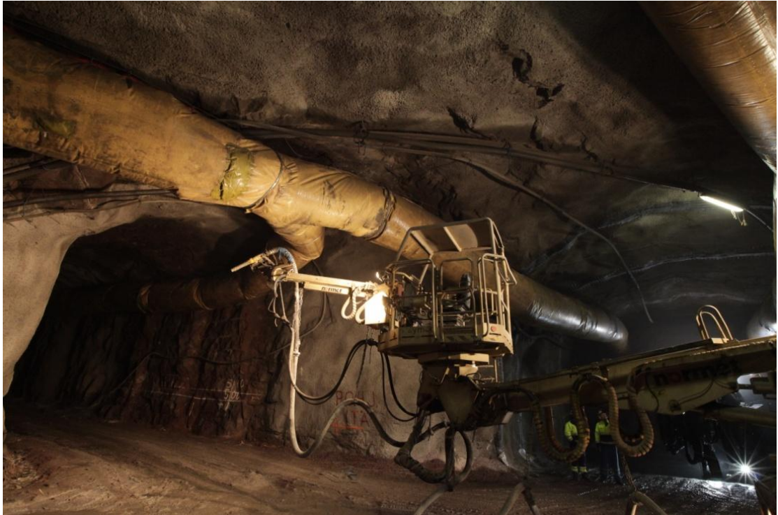
Kuva 6. Kuvassa ruiskurobotti Ruoholahden työmaalla ja tunnelin varusteluja. Kuva: Timo Kotineva
