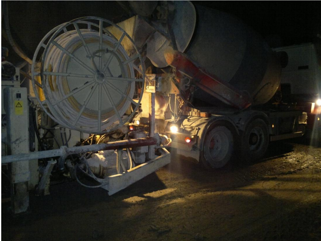
Kuva 8. Ruiskurobotin häntäkaapeli kelalla. kuvassa myös betoniauto asemassa valmiina purkamaan kuorman.
