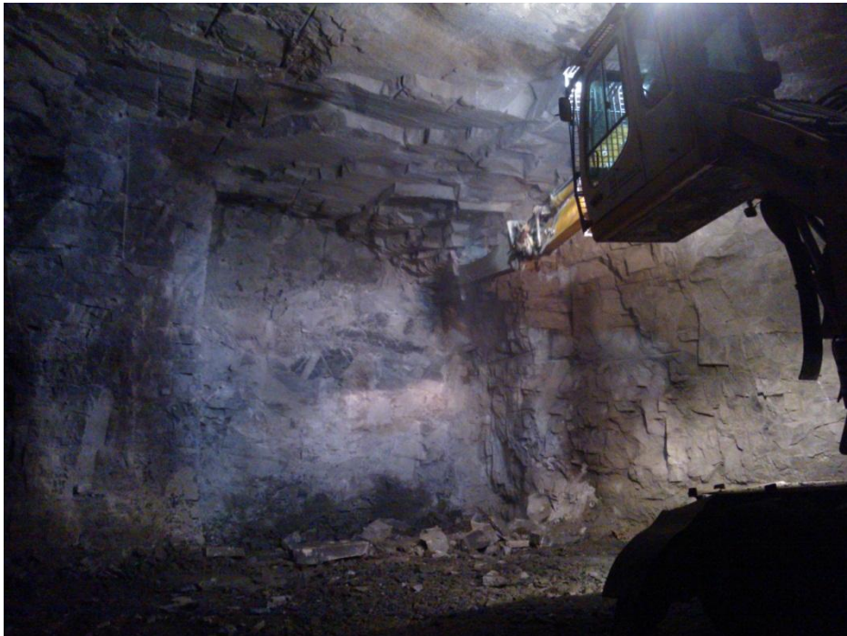
Kuva 1. Kaivinkone rusnaamassa perää lastauksen jälkeen. Kuva: Henri Luhtala.
