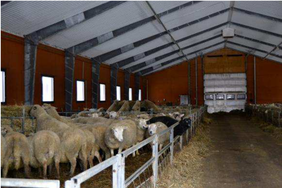
Kuva 12. Käytävä ja katossa ilmastointihormi (Paula Hassinen.)
