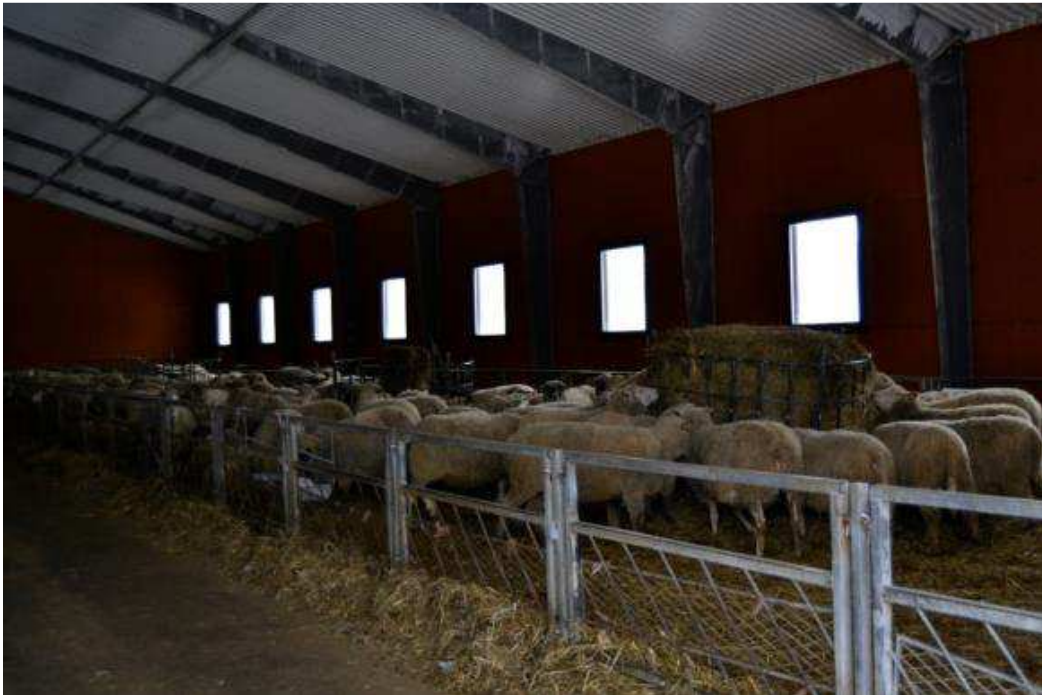
Kuva 11. Karsinaelementtejä, taustalla pyöröpaalihäkki ja seinän teräsrunkopalkit. (Paula Hassinen.)
