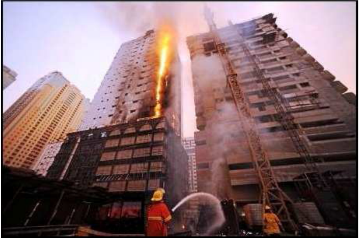
Kuva 12. Ulkokautta levinnyt palo korkeassa rakennuksessa. Julkisivun eristeenä oli käytetty palavaa solumuovieristettä. (FM Global 2012, 13).
