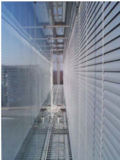
Kuva 17. Kaksoisjulkisivun välitila; lasipintojen väliin asennettu sälekaihtimet (Tenhunen 2003, 41.).
