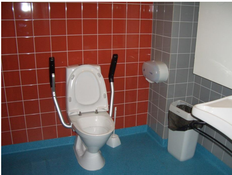
Kuva 20. Terveysaseman yhteydessä oleva liikuntaesteisille mitoitettu wc. (Kuva: Linda Nevalainen.)
