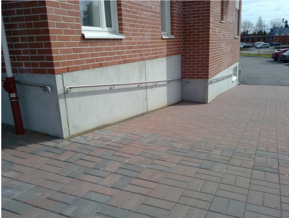
Kuva 11. Suvikuja 2 kerrostalon sisäänkäynnille johtava loivempi mäki. (Kuva: Linda Nevalainen.)
