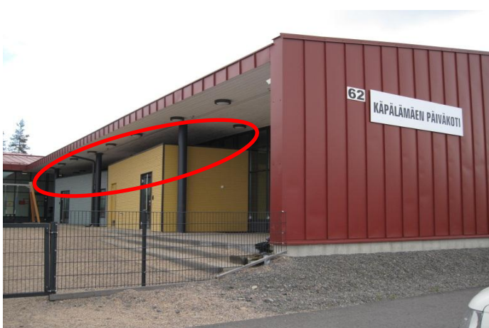
Kuvio 14. Lämpöeristeiden korjaukset.
