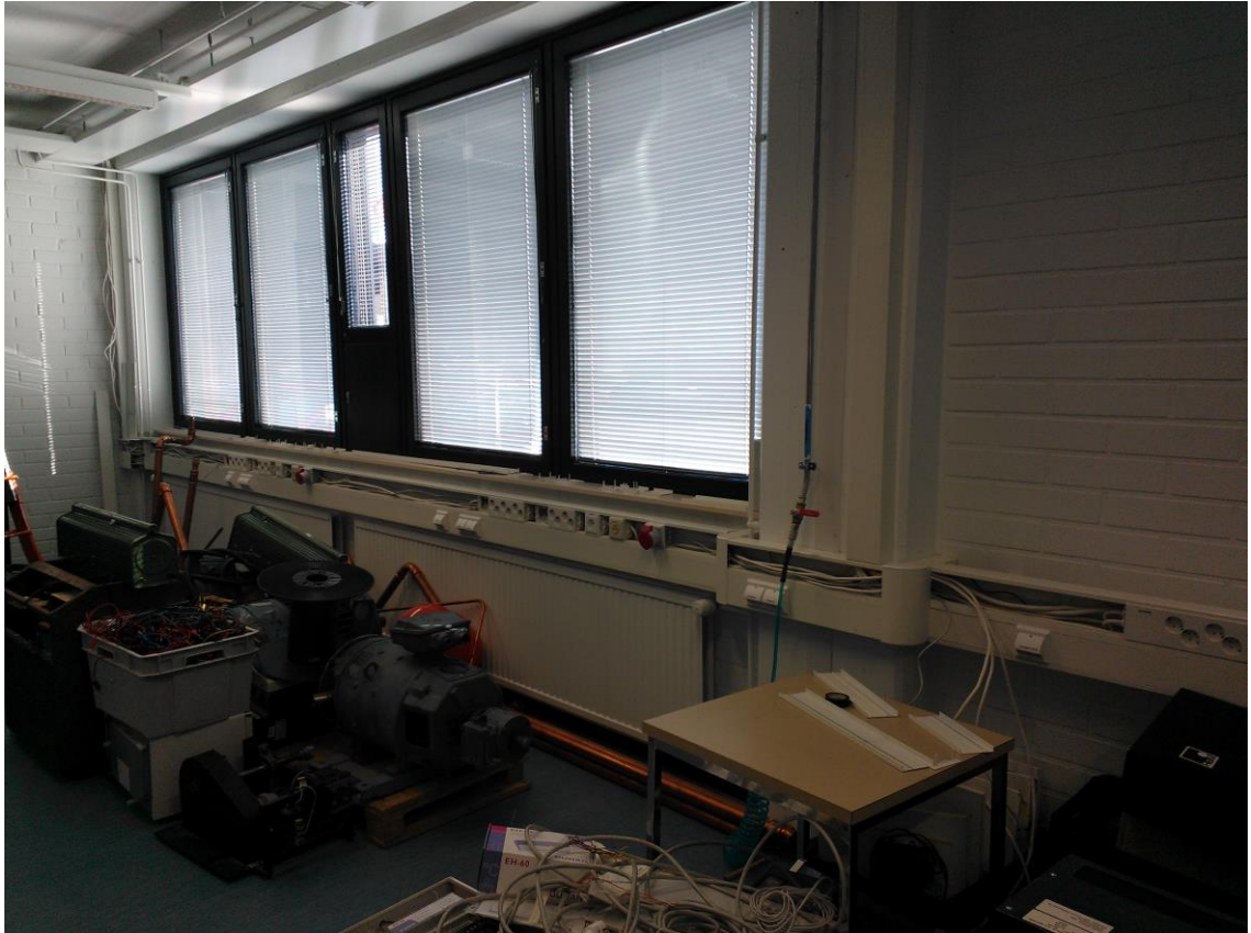
Kuva 2. Kaapelointireitti ohjatuille pistorasioille.
