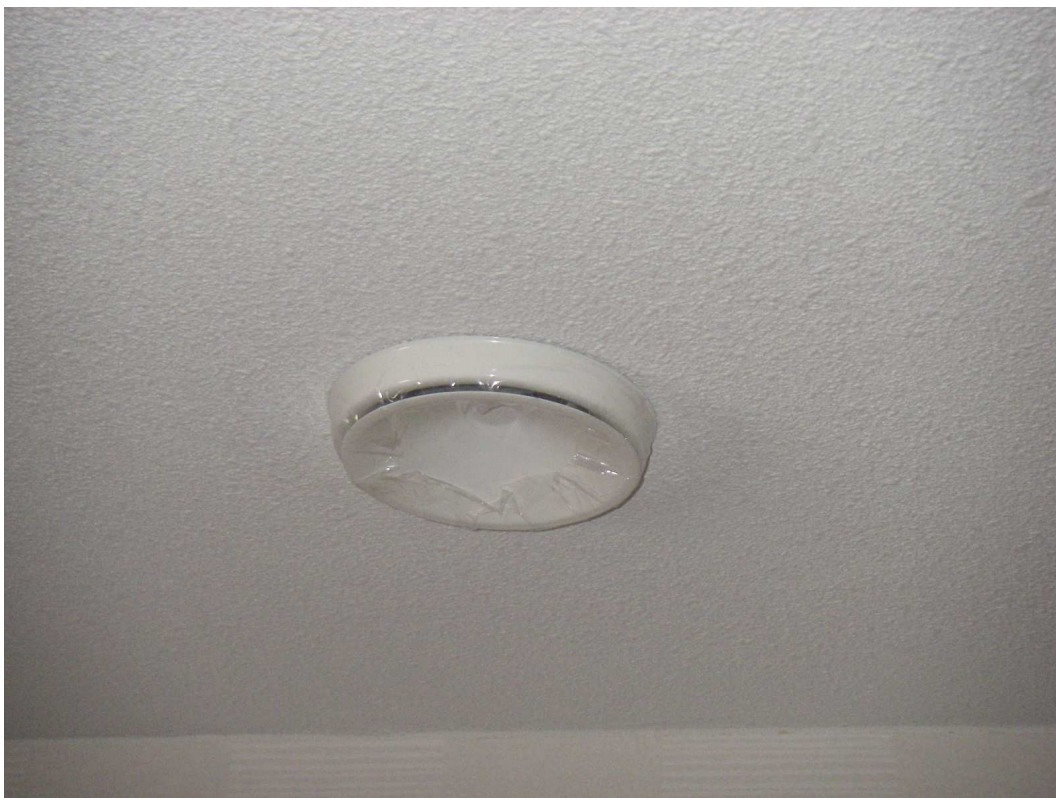
Kuva 7. Ilmanvaihtokanava teipattuna mittauksen ajaksi.
