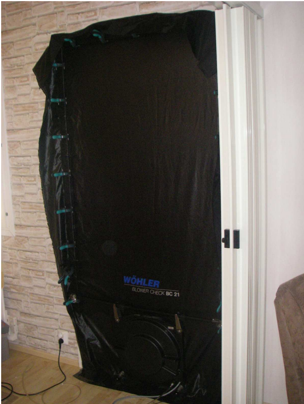
Kuva 8. Ilmanvuotomittauslaitteiston puhallin asennettuna puutalon oveen.
