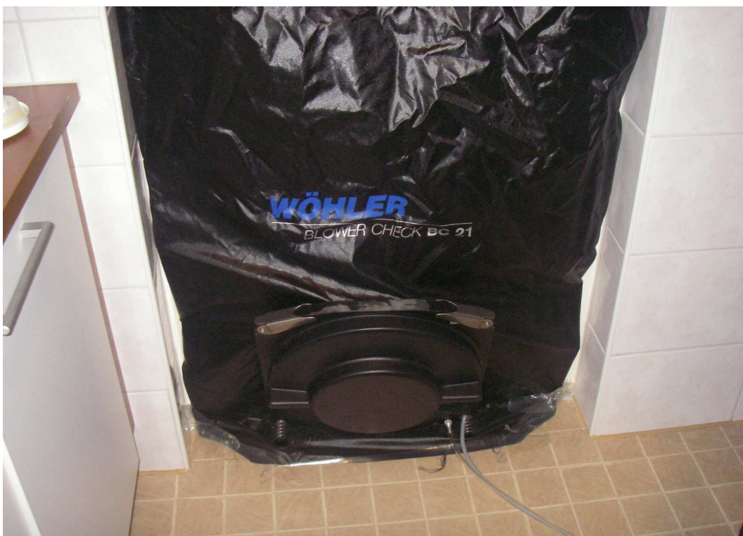
Kuva 5. Ilmanvuotomittauslaitteiston puhallin asennettuna tiilitalon oveen.
